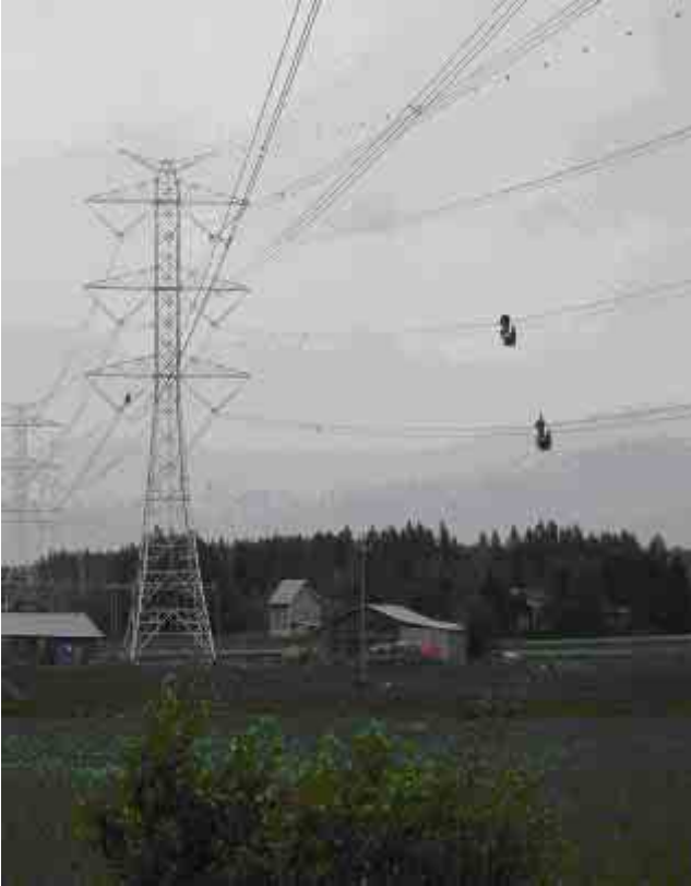
Kuva 6. Johdinten välisiteiden asennusta.
