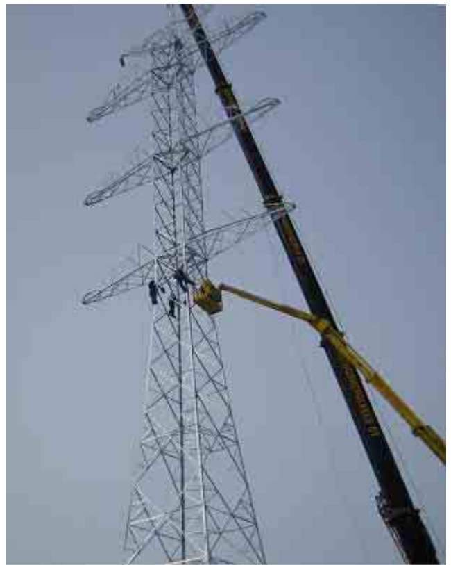
Kuva 5. 400 kV kahden voimajohdon "Tannenbaum"-tyyppisen pylvään pystytystä nostureilla.
