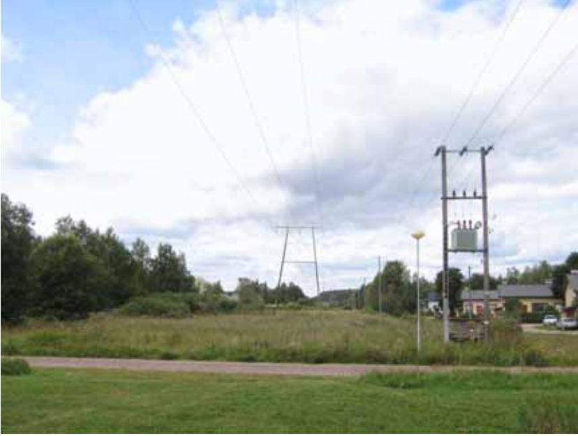
Kuva 42b. Alavaihtoehdon A yhteispylväsratkaisuna toteutettu 400 + 100 kV voimajohto.
