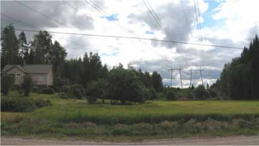
Kuva 93. Hausjärven Karhin alueella nykyisten johtojen läheisyyteen sijoittuu yksittäisiä kiinteistöjä.
