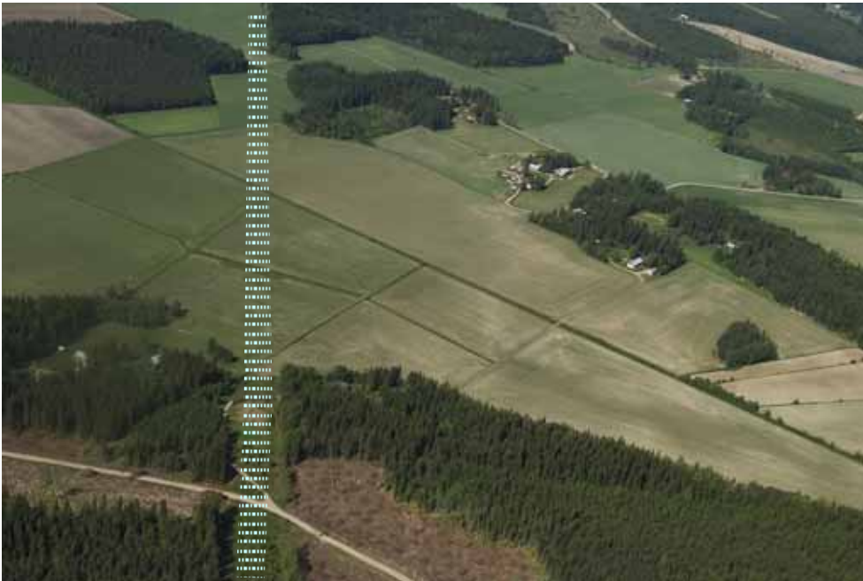
Kuva 31. Viistoilmakuva Hausjärven Vehkaojalta, missä nykyinen voimajohto ylittää noin 1,5 kilometrin levyisen peltoaukean.
