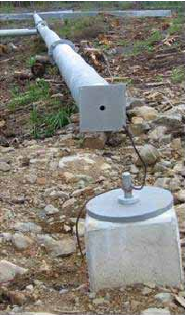
Kuva 10. Pylväsjalan perustus ja maadoituselektrodiin.
