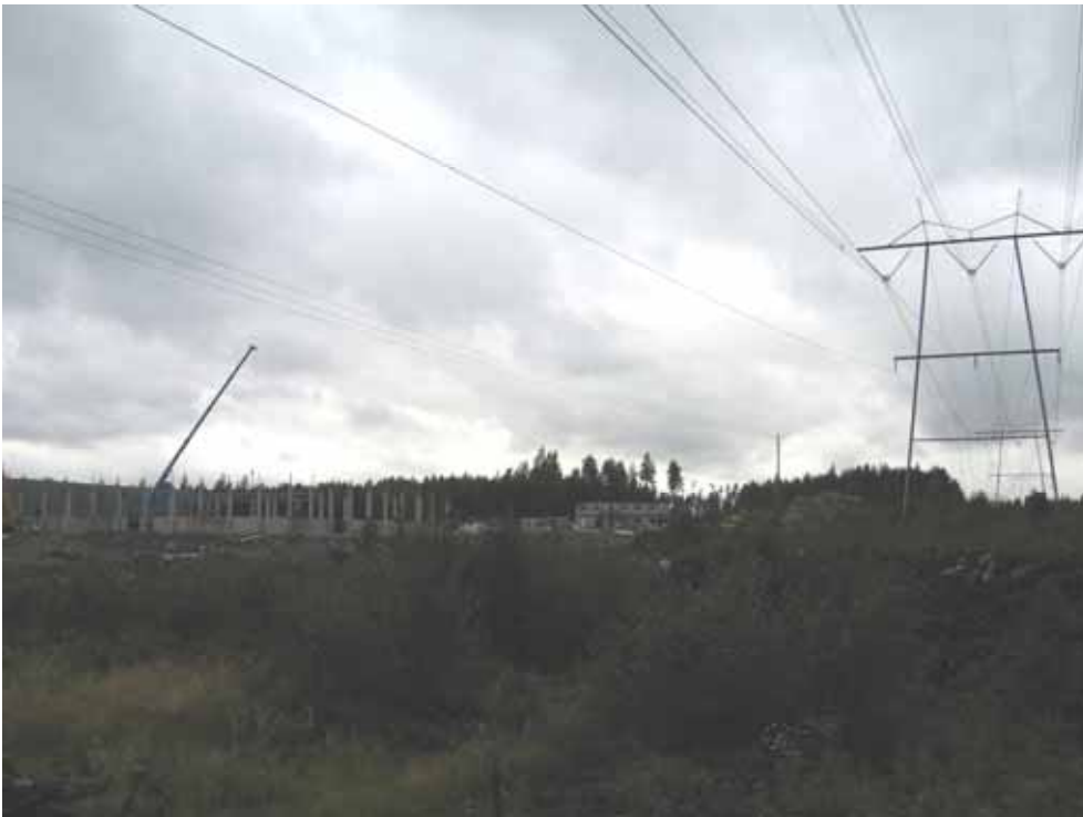
Kuva 56. Uutta teollisuusrakennusta rakennetaan Forssan Hirsikorvessa nykyisten voimajohtojen vierelle.
