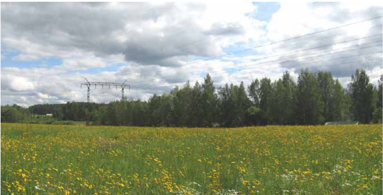
Kuva 28. Janakkalan Toivajoen alueen nykyinen 2x110 kV voimajohto.
