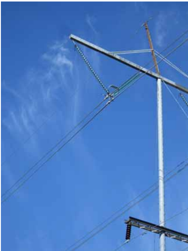
Kuva 86. Onttojen pylväspalkkien päihin on hitsattu levyt naakkojen pesimisen estämiseksi.
