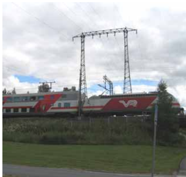
Kuva 3. Nykyinen rautarouva ylittää pääradan Riihimäen Juppalassa. Radasta tulee olla noin 14 metrin vähimmäisetäisyys voimajohdon alimpaan johtimeen.
