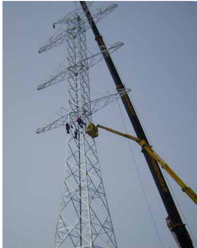
Kuva 11. Jännitetasoltaan 400 kV kahden voimajohdon Tannenbaum-tyyppisen pylvään pystytystä nostureilla.
