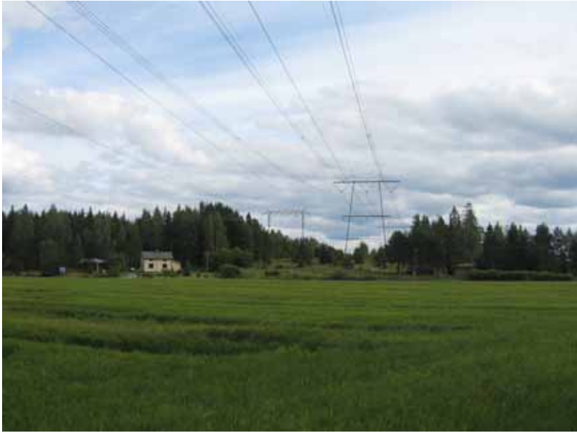
Kuva 41. Havainnekuvapari voimajohtojen sijainnista Tammelan Häiviässä. 2 x 110 kV voimajohdon rinnalle sijoittuu 400 kV voimajohto Vantaan Tammistosta Ulvilaan. Yläkuvassa nykytilanne ja alakuvassa suunniteltu 400+110 kV voimajohto ja Tammisto - Ulvila 400+110 kV voimajohto.
