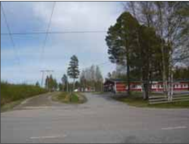
Kuva 135. Kokkolan Alaviirteen koulu voimajohdojen itäpuolella.
