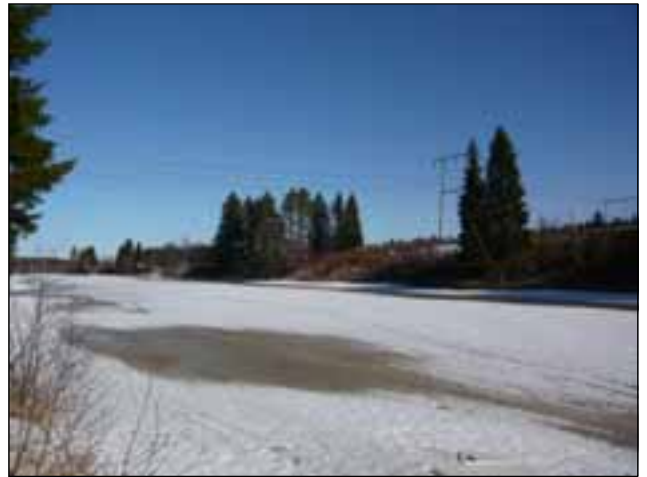
Kuva 30. Voimajohto ylittää Pyhäjoen uoman Merijärven Pyhäkoskella. Tämä Pyhäjoen alaosa lukeutuu suojeltaviin jokiin.
