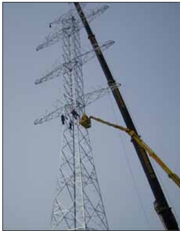
Kuva 9. Jännitetasoltaan 400 kV kahden voimajohdon Tannenbaum-tyyppisen pylvään pystytystä nostureilla.
