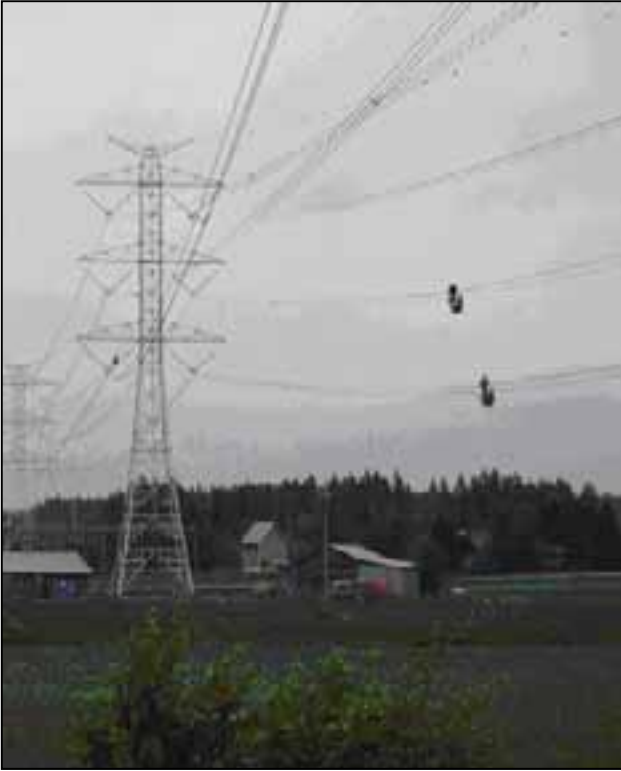
Kuva 10. Johdinten välisiteiden asennusta.
