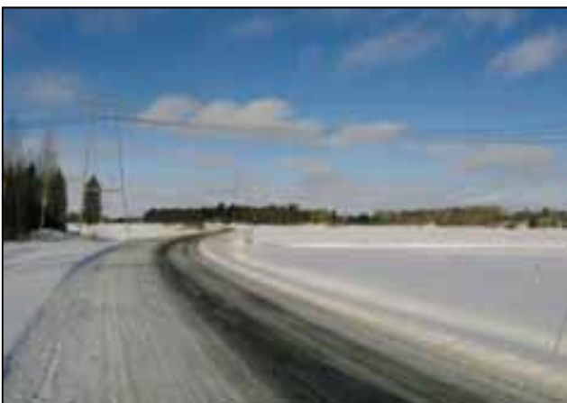
Kuva 132. Havainnekuvapari Jokikylästä. Yläkuvassa on kuvattu nykytilanne ja alhaalla suunniteltu 400 kV voimajohto (VE B).
