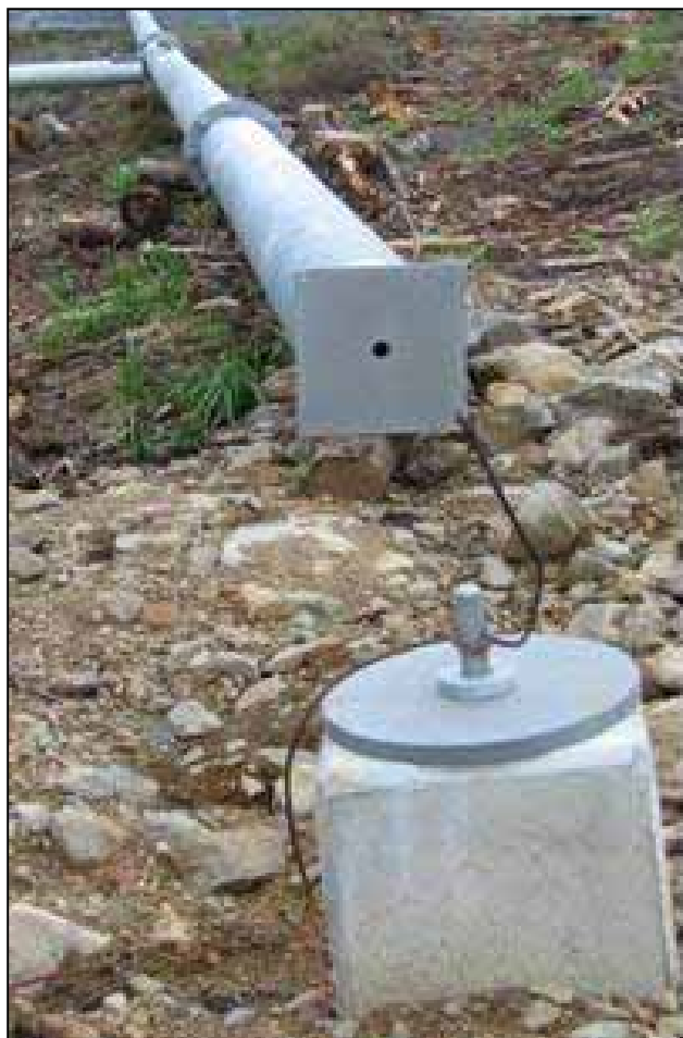
Kuva 8. Pylväsjalan perustus ja maadoituselektrodijohdin.
