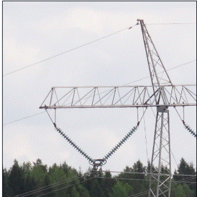
Kuva 6.5. Voimajohtopylvään eristimiä, joissa koronapurkauksia voi esiintyä.
