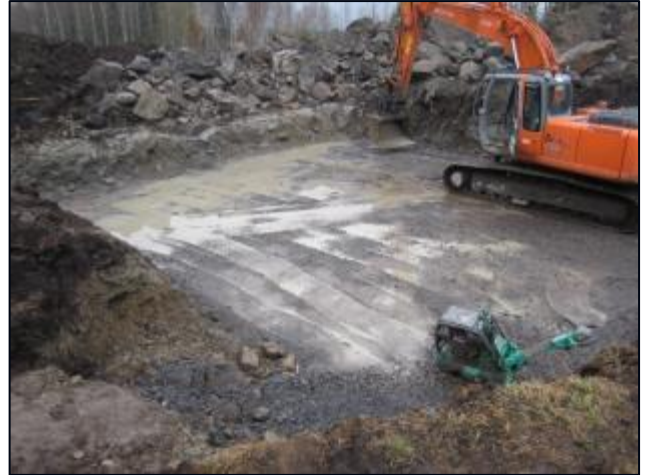
Kuva 3.6. Vapaasti seisovan pylvään perustuksen pohjatöitä
