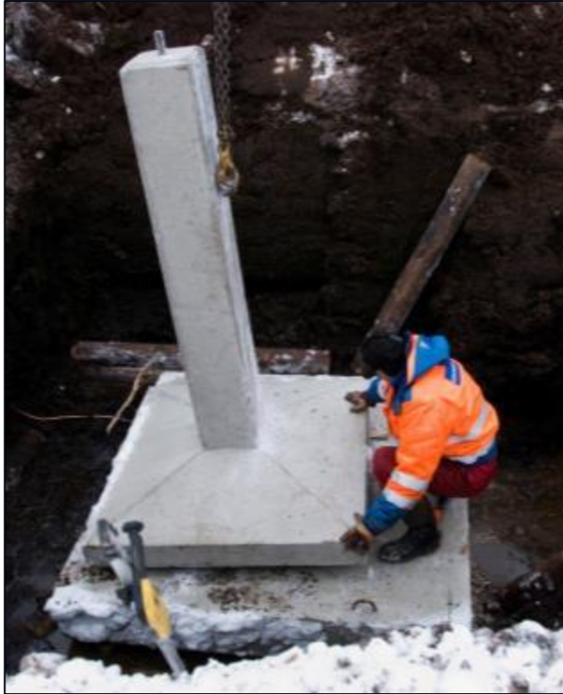
Kuva 3.4. Harustetun pylvään perustuselementin asentaminen.
