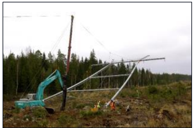
Kuva 3.7. Voimajohtopylvään pystytys.
