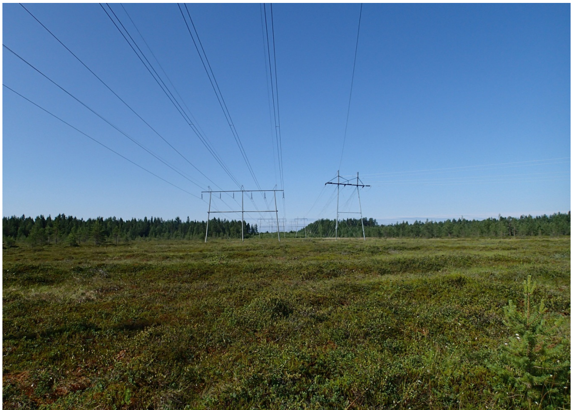
Kuva 14. Johtoreittiä Niinisuon alueella voimajohdon kulmakohdasta länteen päin nähtynä
