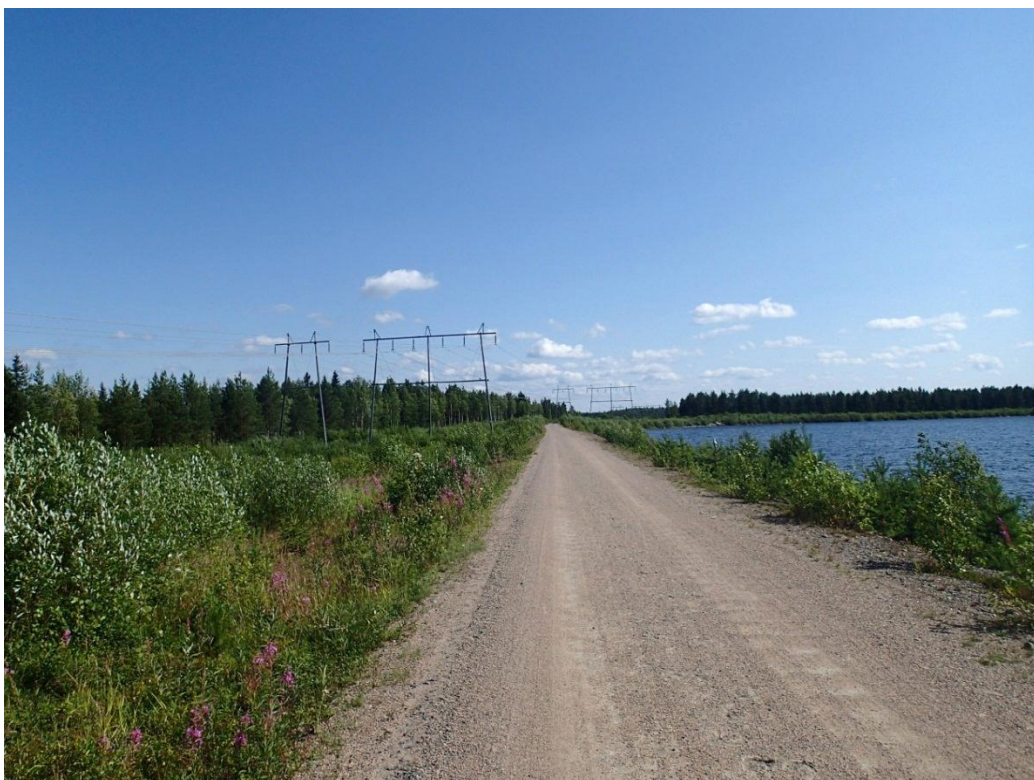
Kuva 20. Johtoreittiä Ijoen pohjoisrannan tulvapengertien vierellä
