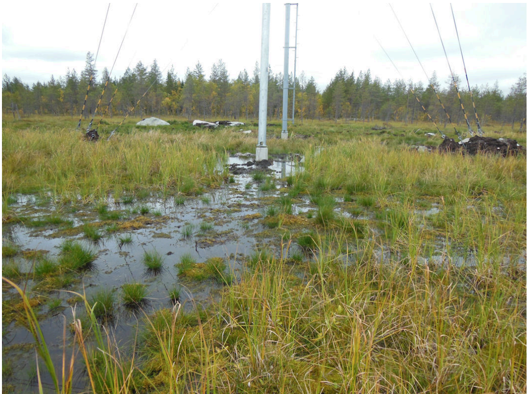
Kuva 7. Pylvään rakentamisesta aiheutuu muutoksia lähinnä perustustöiden alueella. Kuva vuonna 2016 rakennetulta 110 kilovoltin voimajohdolta Simon Karhumaansuolta 29.8.2017.
