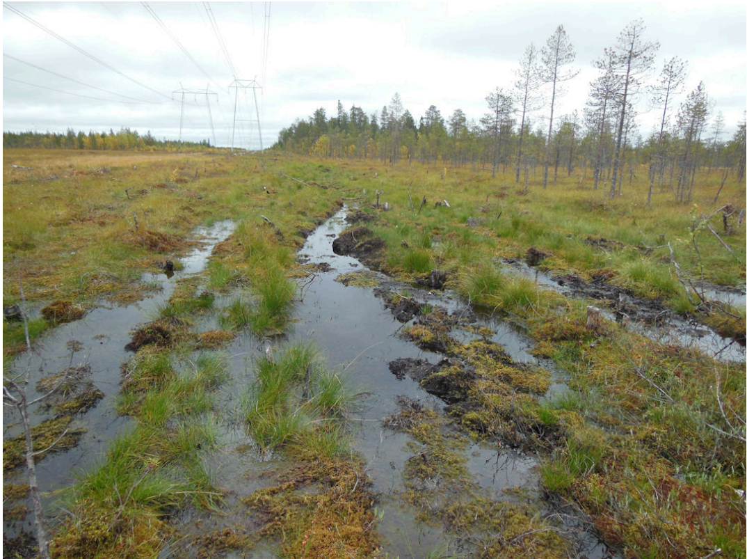
Kuva 6. Mikäli rakentamisessa ei käytetä telapohjaisia työkoneita ja/tai rakentaminen toteutetaan sulan maan aikaan, syntyy suon pintaan herkästi kulku-uria ja kasvukerros rikkoutuu. Kuva vuonna 2016 rakennetulta 110 kilovoltin voimajohdolta Simon Karhumaansuolta 29.8.2017.
