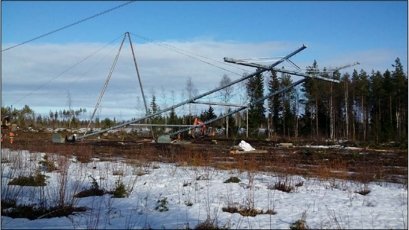
Kuva 9. Voimajohtopylvään pystytys.
