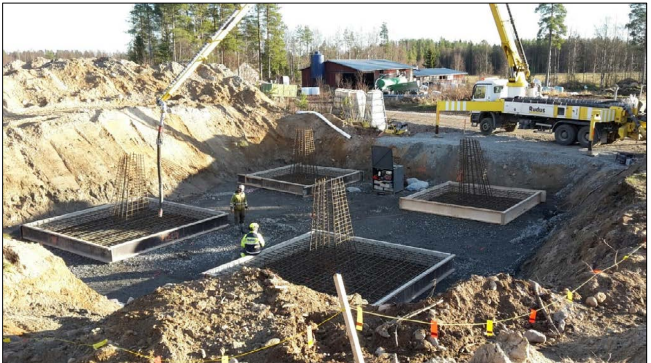
Kuva 8. Vapaasti seisovan pylvään perustuksen pohjatöitä.
