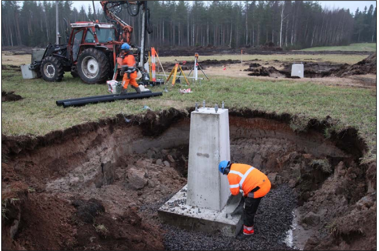
Kuva 7. Pylvään perustuselementin asentaminen.
