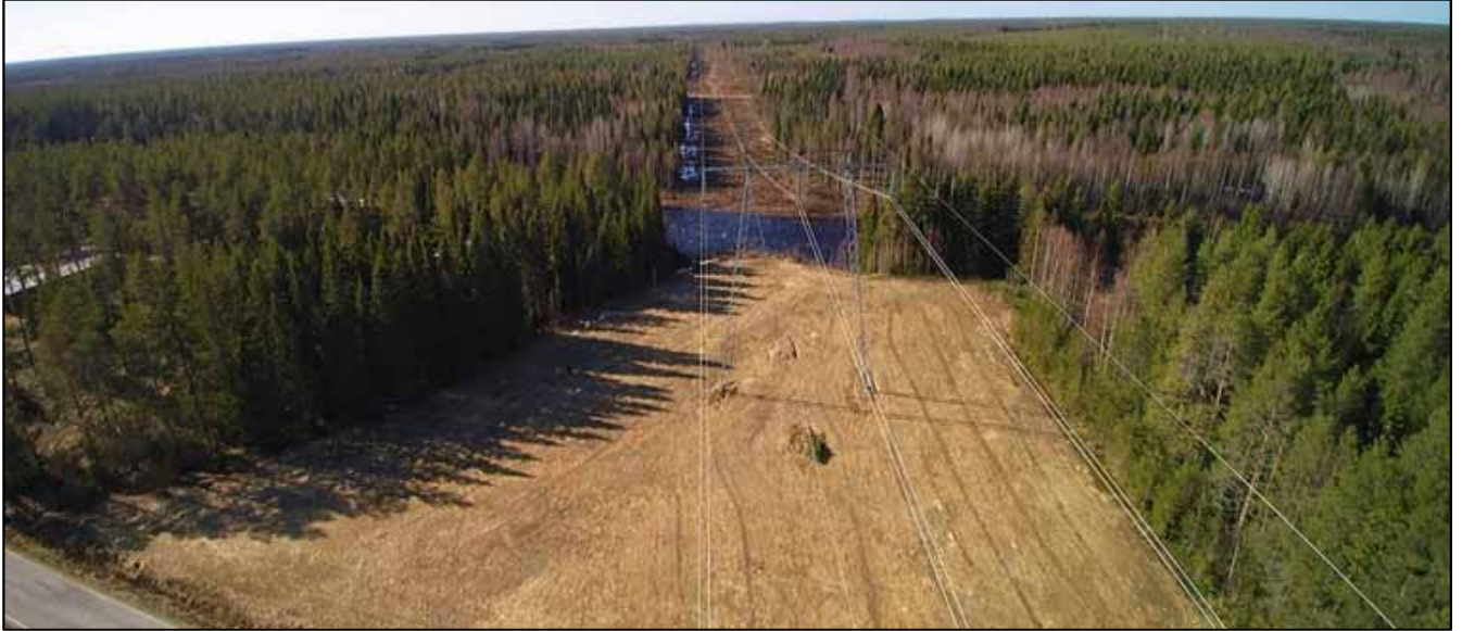
Kuva 79. Näkymä Kuivajoen ylityskohdasta, jossa jokirannat ovat peitteisiä. Uusi voimajohto sijoittuu nykyisen voimajohdon oikealle puolelle. Kuva kaakosta luoteeseen.
