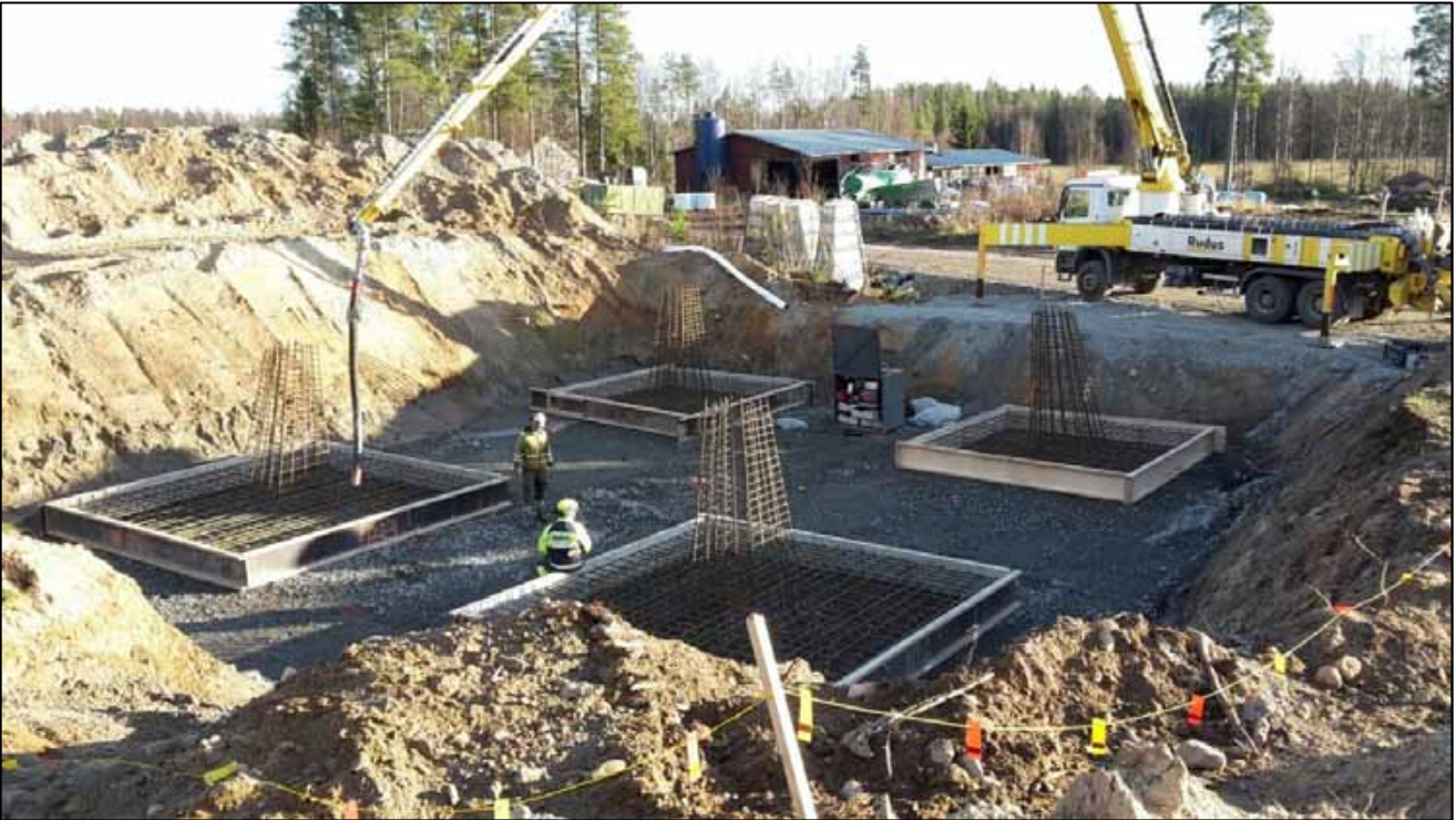
Kuva 8. Vapaasti seisovan pylvään perustuksen pohjatöitä.
