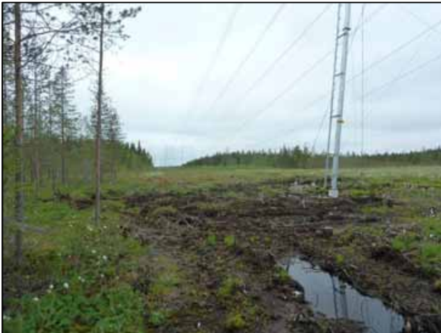
Kuva 102. Perustusten rakentaminen ja pylväiden pystytys voivat vaurioittaa suoalueilla kasvukerrosta. Tätä voidaan tehokkaasti ehkäistä ajoittamalla rakentaminen lumipeitteeseen aikaan ja käyttämällä telapohjaisia työkoneita.
