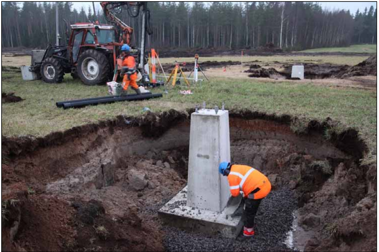
Kuva 7. Pylvään perustuselementin asentaminen.
