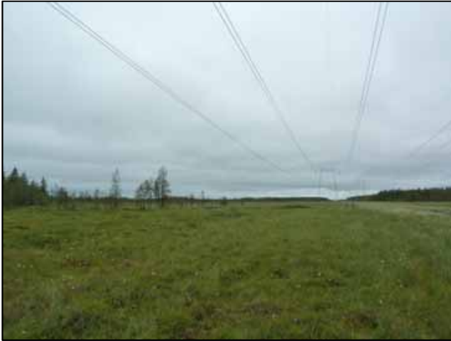
Kuva 101. Vähäpuustoisella suolla voimajohdon aiheuttama muutos on seurausta puiden poistosta. Suon rehevyydestä ja vesitaloudesta riippuen kenttä- ja pohjakerroksen kasvillisuus ei juurikaan muutu tai se voi muuttua heinittyneemmäksi, rehevämmillä paikoilla luhtaisemmaksi.
