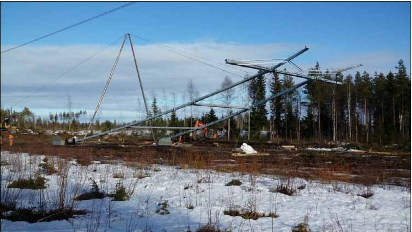
Kuva 9. Voimajohtopylvään pystytys.
