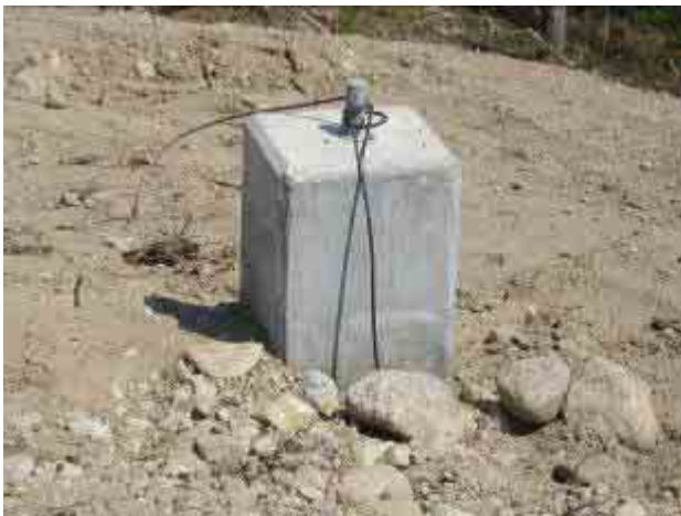
Kuva 8. Pylväsjalan perustus ja maadoituselektrodijohdin.
