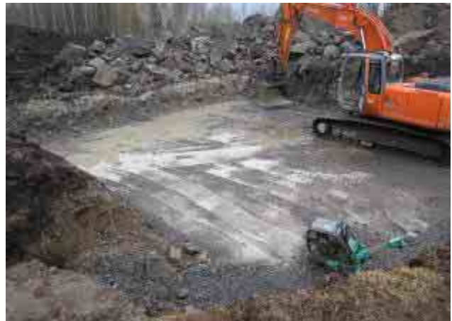
Kuva 7. Vapaasti seisovan pylvään perustuksen pohjatöitä.
