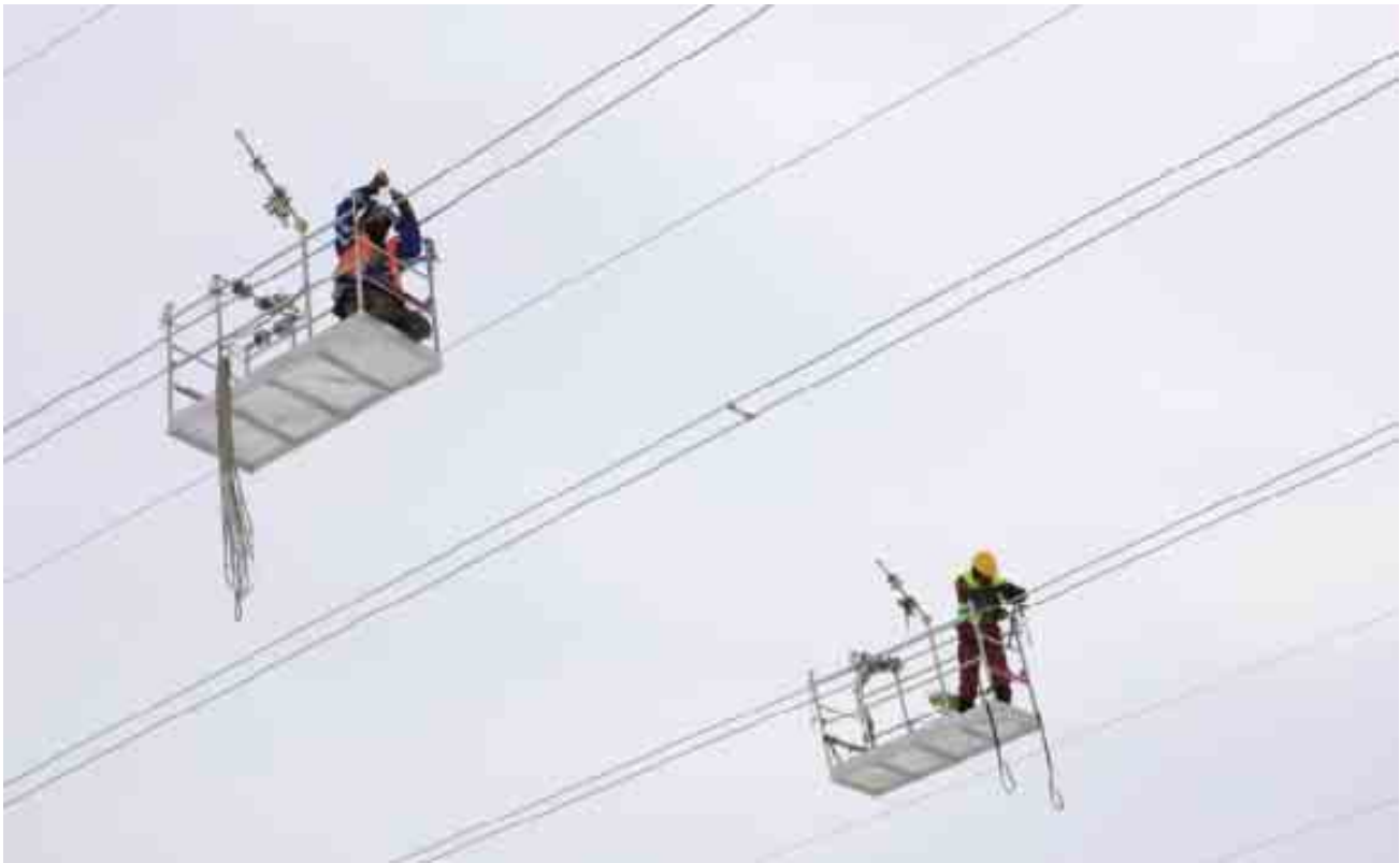
Kuva 11. Johdinten välisiteiden asennusta.
