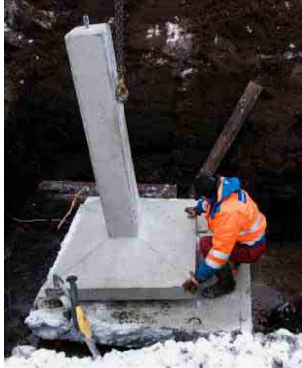
Kuva 6. Harustetun pylvään perustuselementin asentaminen.
