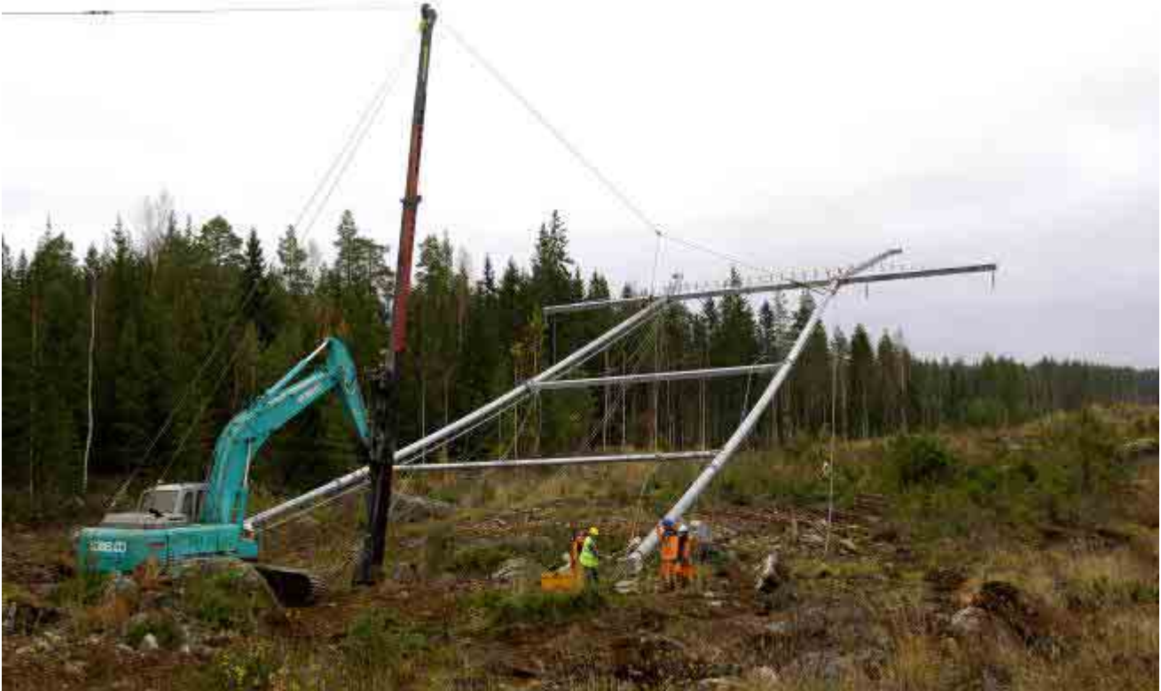
Kuva 10. Voimajohtopylvään pystytys.
