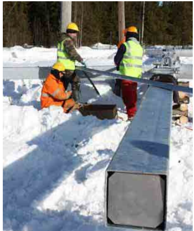
Kuva 9. Voimajohtopylvään kokoamista pylväs paikalla.
