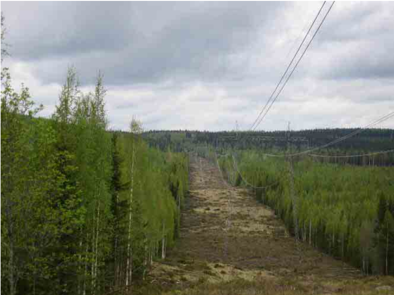
Kuva 38. Voimajohdon säännöllisesti raivattava johtoaukea.
