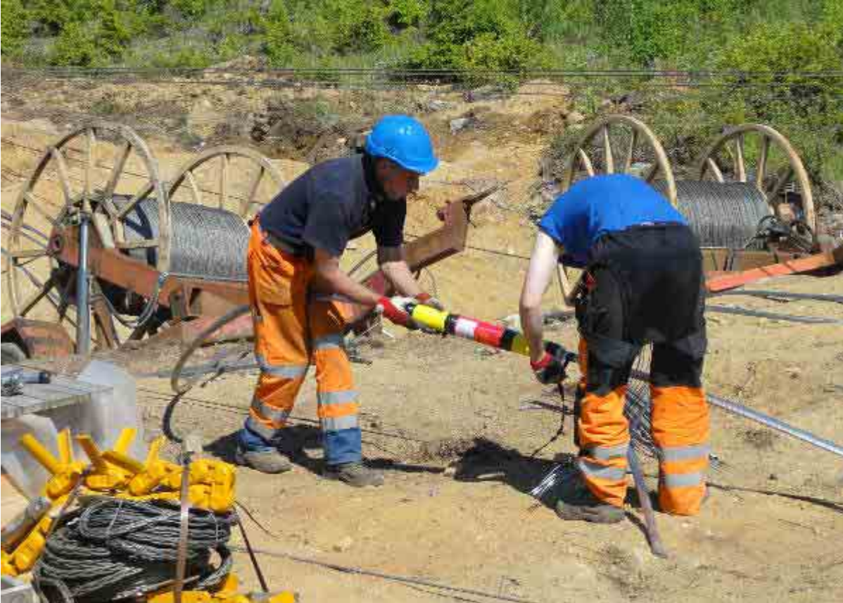
Kuva 152. Voimajohtojen johdinten liittämässä käytetään räjäytettäviä liittoksia.
