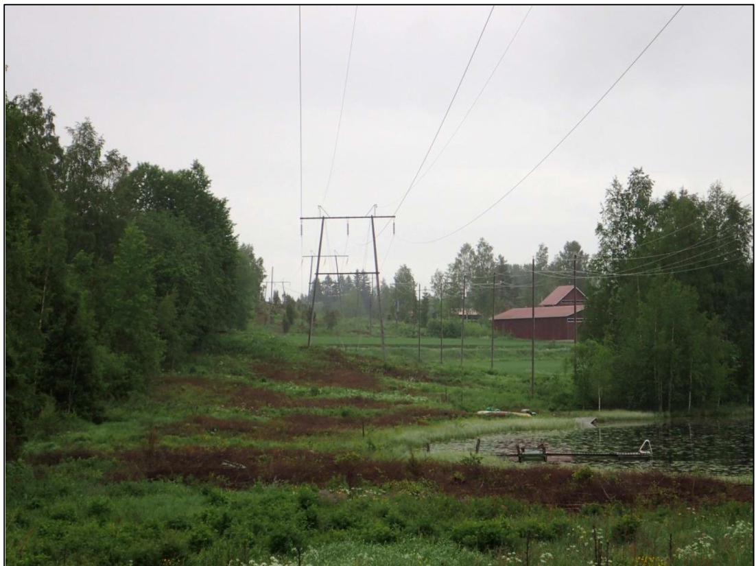
Kuva 7.2. Voimajohtoreittiä Oksilammen luoteisrannalla.
