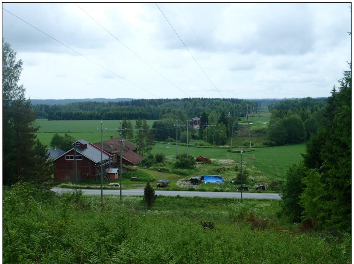
Kuva 5.6. Pinsiönkankaantien varrella on asutusta alle 100 metrin etäisyydellä voimajohtosta. Voimajohtoa lähimmät rakennukset ovat talousrakennuksia.
