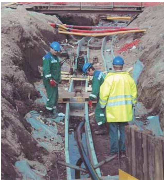
Kuva 3-20. 110 kV kaapelien asennustyö, Helen Sähköverkko Oy.
