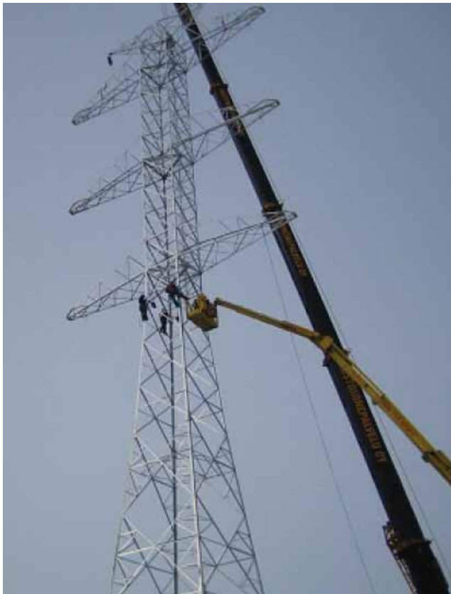
Kuva 3-2. 400 kV kahden voimajohdon "Tannenbaum"-tyyppisen pylvään pystytystä nostureilla.
