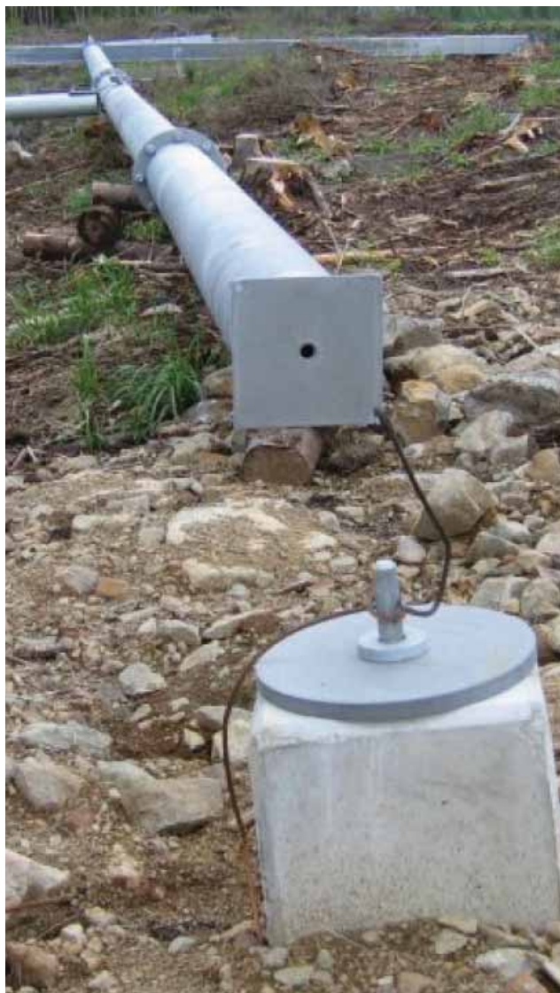
Kuva 3-1 Voimajohtopylvään perustus ja maadoituselektrodijohdin.
