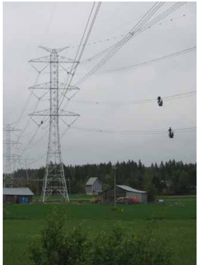
Kuva 3-3. Johdinten välisiteiden asennus.
