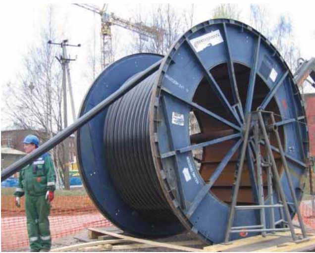
Kuva 3-22. 110 kV kaapelin purku kaapelikelalta, Helen Sähköverkko Oy.
