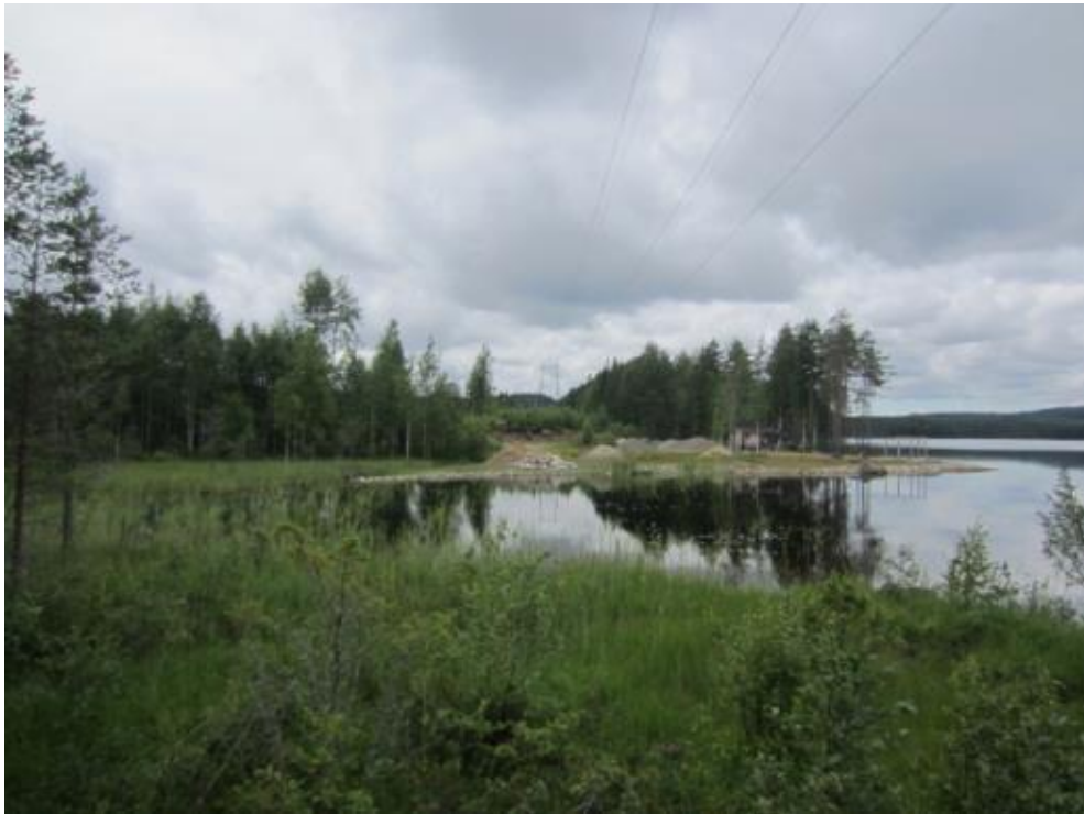
Kuva 4-2 Voimajohto ylittää Marpanlammen etelärannan.
