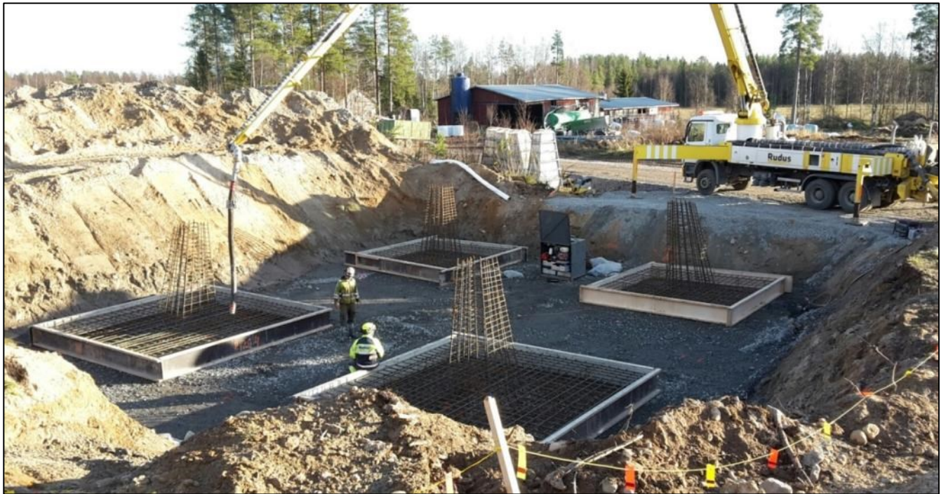
Kuva 3.5. Vapaasti seisovan pylvään perustuksen pohjatöitä.
