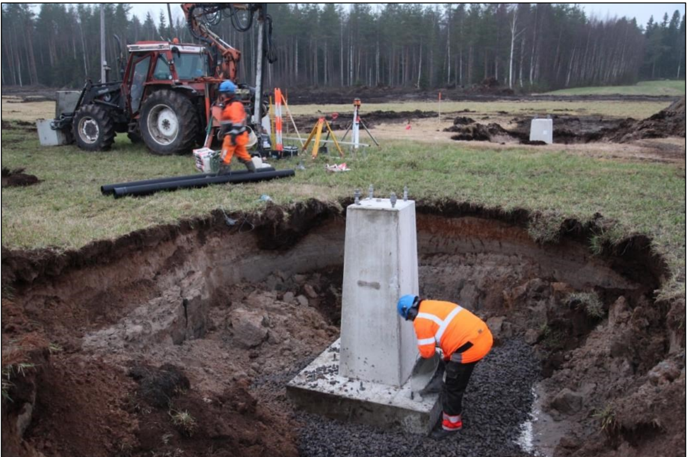
Kuva 3.4. Pylvään perustuselementin asentaminen.
