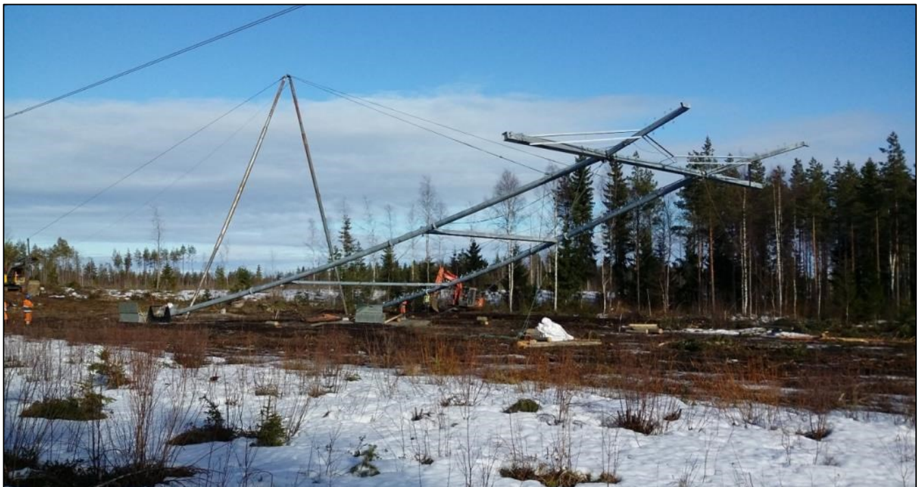
Kuva 3.6. Voimajohtopylvään pystytys.
