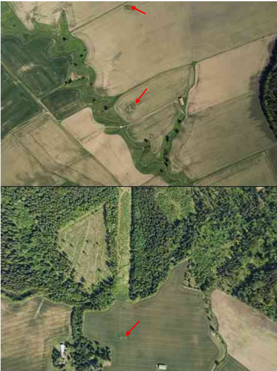
Kuva 8-1. Tarkasteltava voimajohto sijoittuu maa- ja metsätalousalueille. Nuolet osoittavat ilmakuvista nykyiset voimajohtopylväät. Alemmassa kuvassa erottuu metsäalueella johtoaukea.
