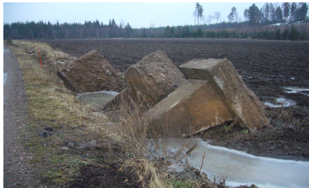
Kuva 10-1. Jatkokuljetusta odottavia pellolta poistettuja betoniperustuksia. Pylväsperustuksia on neljä jokaista ns. Rautarouvan pylvästä kohti. Perustuksen koko on noin 1,5–2,4 m 3 ja paino keskimäärin noin 4 500 kg.
