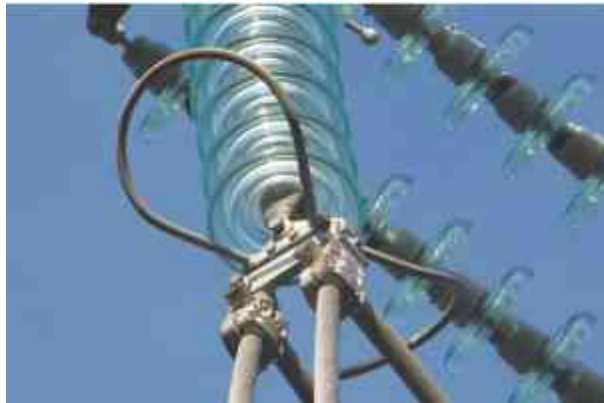
Kuva 9-2. Voimajohtopylvään eristimiä, joissa koronapurkauksia voi esiintyä.
