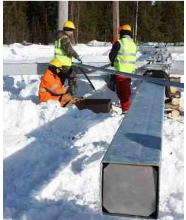
Kuva 3-3. Voimajohtopylvään kokoamista pylväspaikalla.
