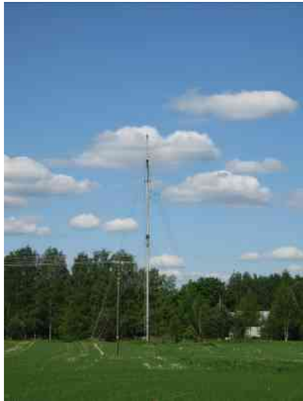
Kuva 9-3. Harustuenta sivusuunnasta katsottuna.
