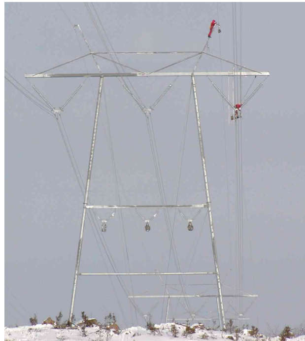
Kuva 4-2. Harustettu kaksijalkainen portaalipylväs.
