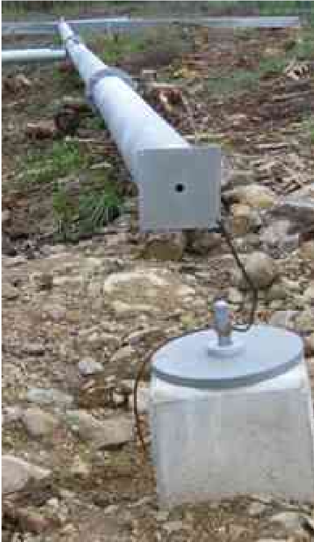
Kuva 3-2. Pylväsjalan perustus ja maadoituselektrodijohdin.
