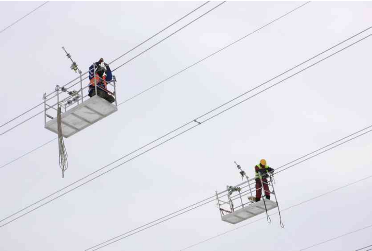
Kuva 3-4. Johdinten välisiteiden asennusta.
