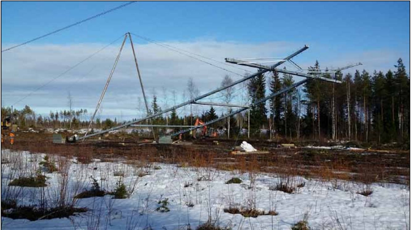
Kuva 10. Voimajohtopylvään pystytys.
