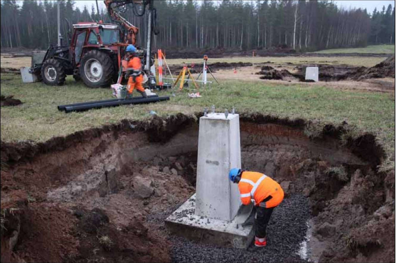
Kuva 8. Pylvään perustuselementin asentaminen.
