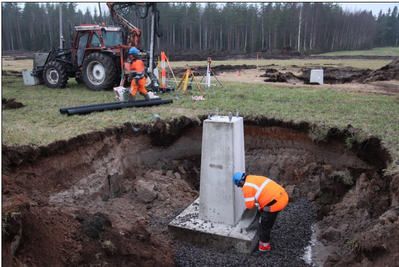
Kuva 10. Pylvään perustuselementin asentaminen.
