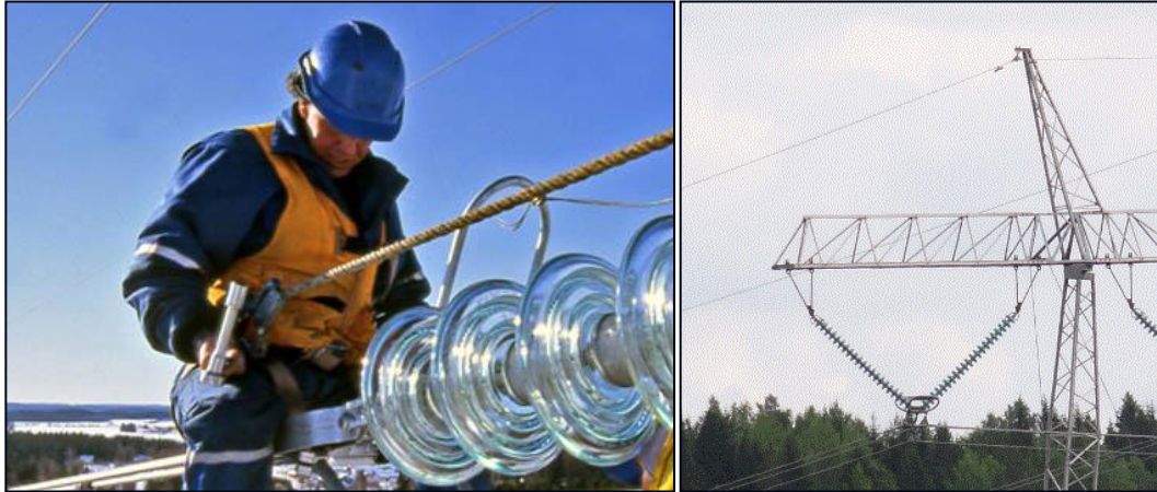
Kuva 70. Voimajohtopylvään eristimiä, joissa koronapurkauksia voi esiintyä.
