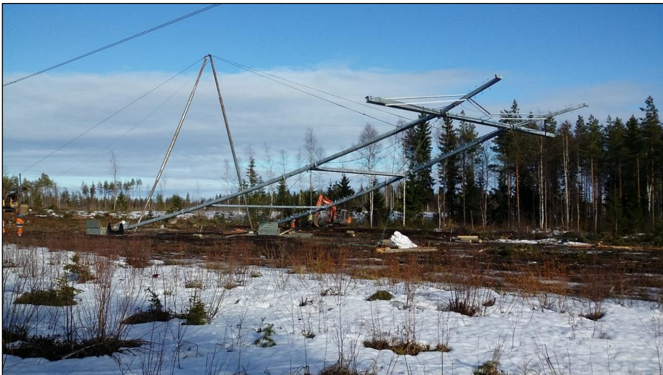
Kuva 12. Voimajohtopylvään pystytys.
