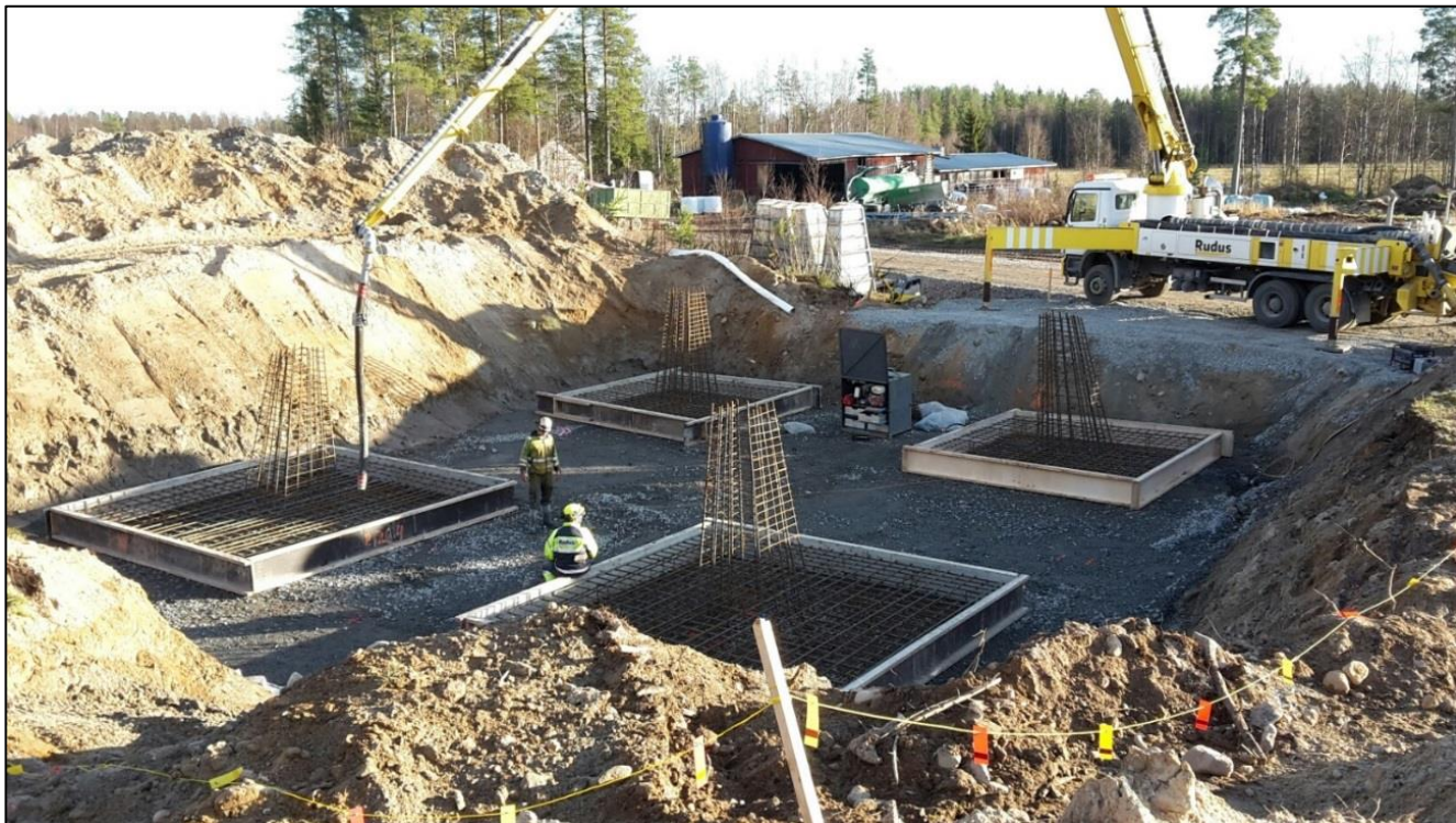
Kuva 11. Vapaasti seisovan pylvään perustuksen pohjatöitä.
