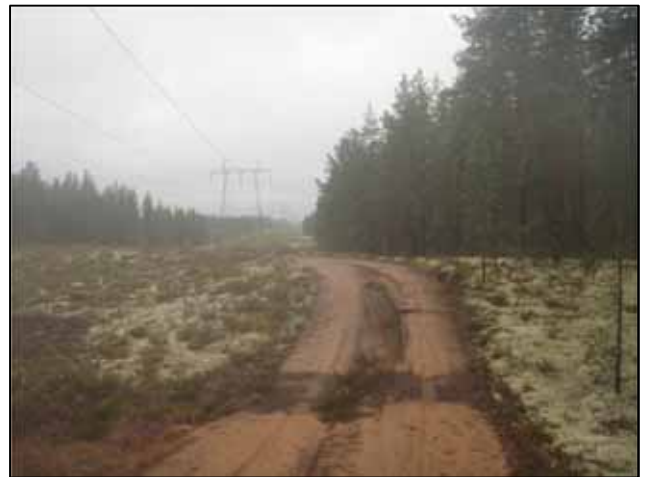
Kuva 73. Voimajohtoalue erottuu avoimena ympäristönä Rokuan muodostuman alueella. Kuva reittivaihtoehdolta 3C 2.
