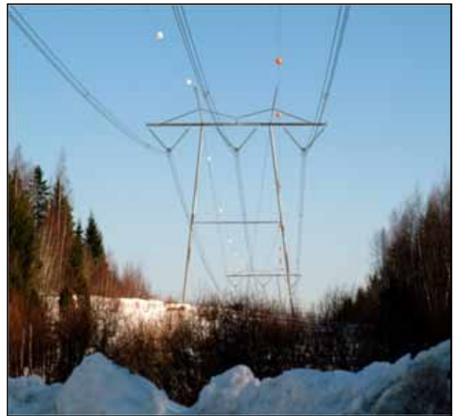
Kuva 77. Lintujen törmäysriskiä voidaan pienentää merkitsemällä johtimet riskialttiissa kohdissa huomiopalloilla.
