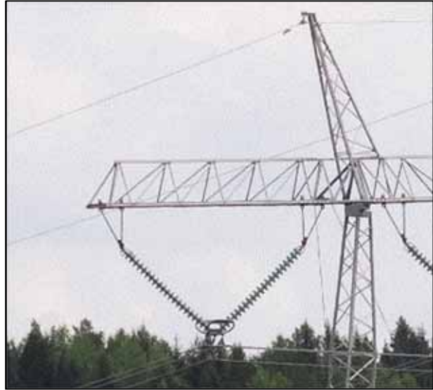
Kuva 163. Voimajohtopylvään eristimiä, joissa koronapurkauksia voi esiintyä.
