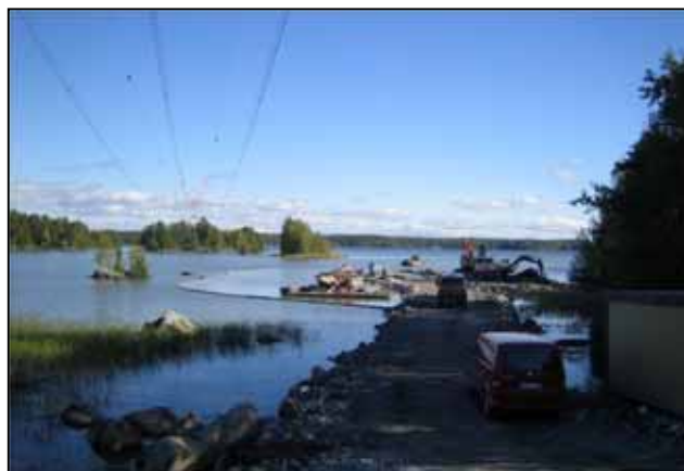
Kuva 23. Lähellä rantaa sijaitsevan vesistöpylvään rakentaminen vaatii yleensä väliaikaisen tieyhteyden.
