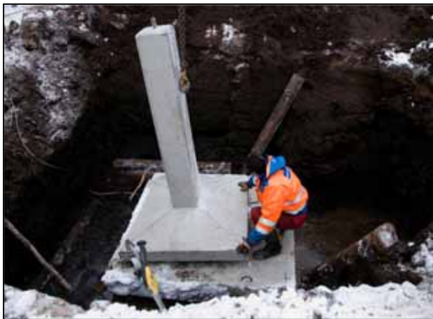
Kuva 9. Harustetun pylvään perustuselementin asentaminen.
