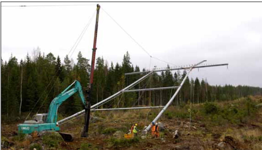
Kuva 13. Voimajohtopylvään pystytys.
