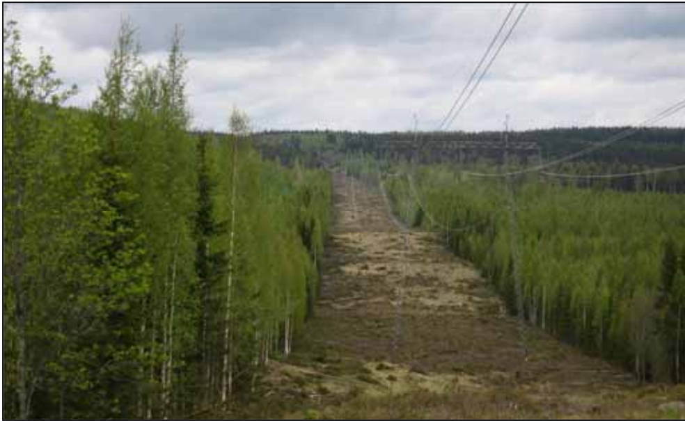
Kuva 42. Voimajohdolle raivataan puuttomana pidettävä johtoaukea.
