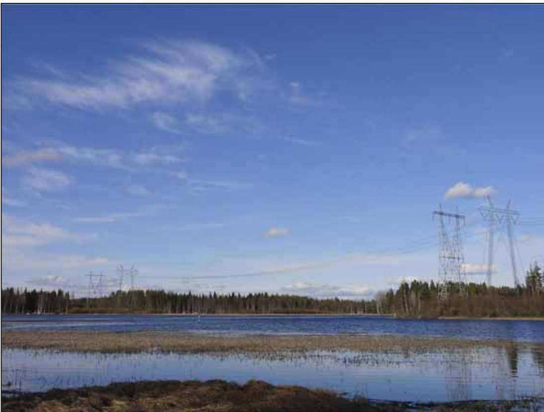
Kuva 92. Kuva nykytilanteesta (yllä) ja havainnekuva tutkittavasta tilanteesta (alla) Kinnulassa Kinnulanlahden Kierinlahden kohdalla.
