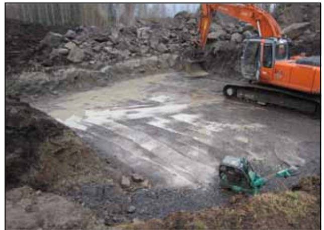
Kuva 10. Vapaasti seisovan pylvään perustuksen pohjatöitä.
