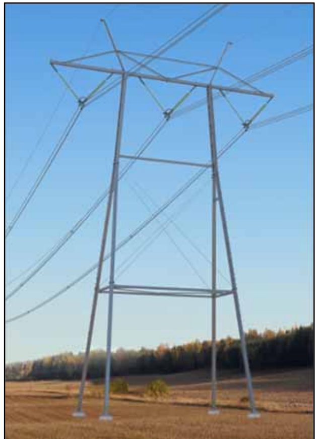
Kuva 21. Harustamaton 400 kilovoltin portaalipylväs (havainnekuva).
