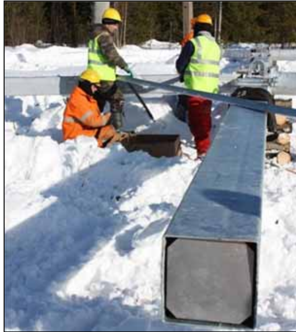
Kuva 12. Voimajohtopylvään kokoamista pylväsmaalla.
