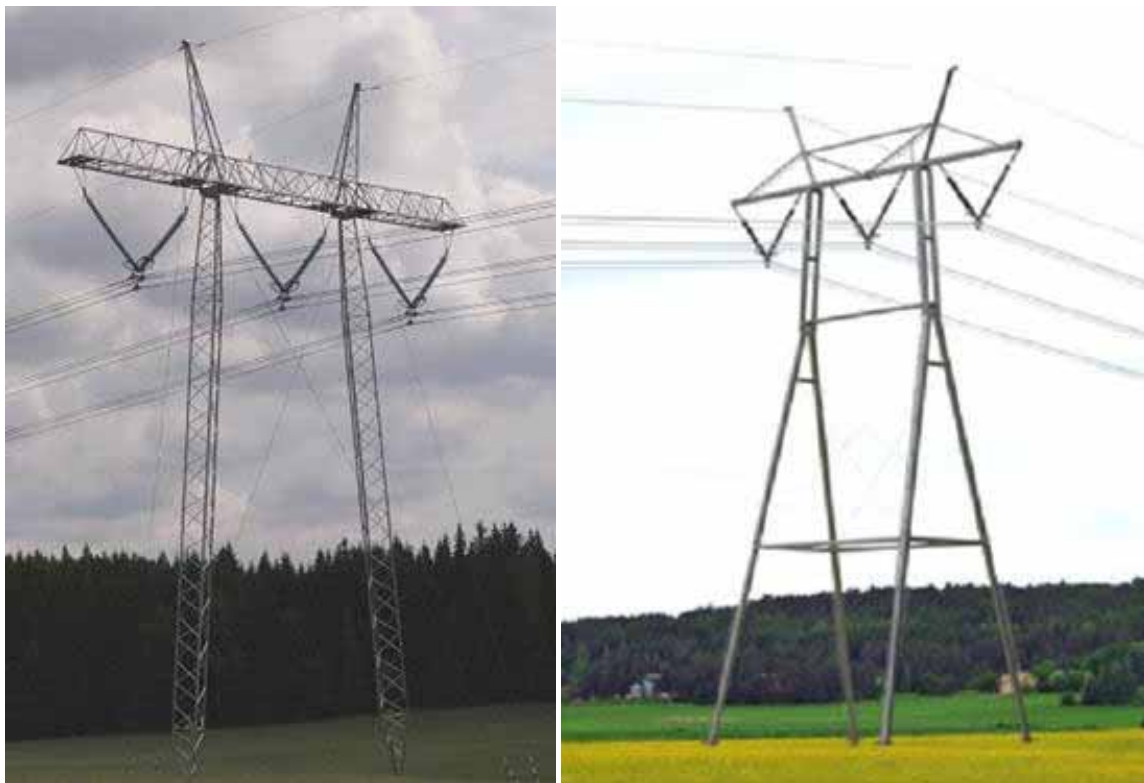
Kuva 10. Harustettu 400 kilovoltin portaalipylväs (vasemmalla) ja harustamaton 400 kilovoltin portaalipeltopylväs (oikealla, havainnekuva).
