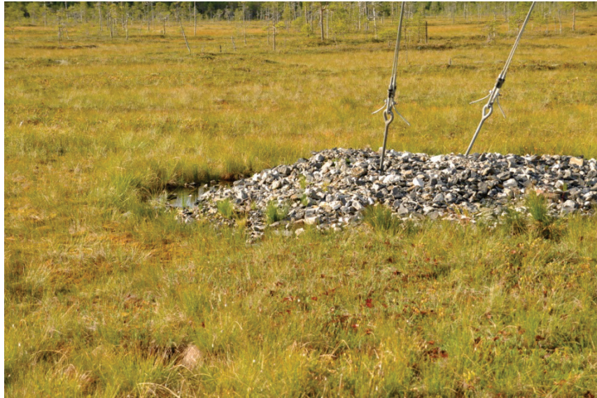
Kuva 9. Karuilla ja keskiravinteisilla avosoilla pylväsperustukset eivät juurikaan muuta ympäröivää suoaluetta.
