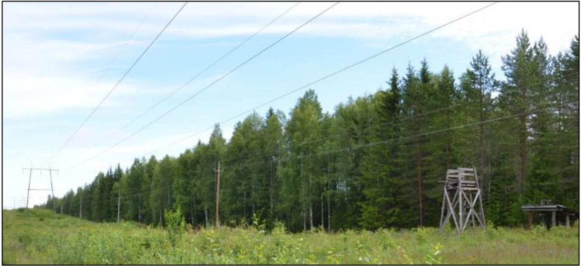
Kuva 4-1. Hirvitorni, joka sijaitsee Joroisilla tarkasteltavan voimajohdon alla.
