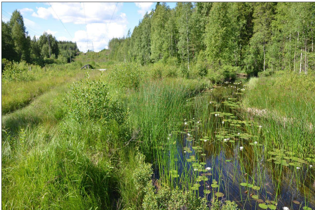
Kuva 6-19. Voimajohto ylittää Lanajoen.
