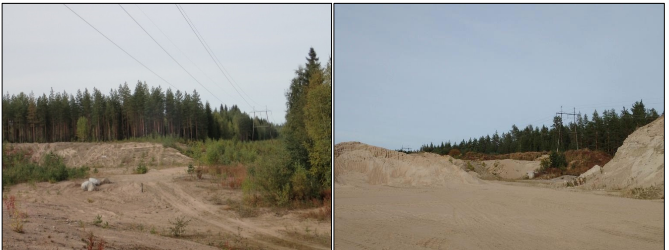
Kuva 7.10. Soranottoa voimajohtoalueen länsipuolella Harisenmäen etelärinteessä Laukaalla (vasemmalla) ja Mustimäellä Laukaalla (oikealla).
