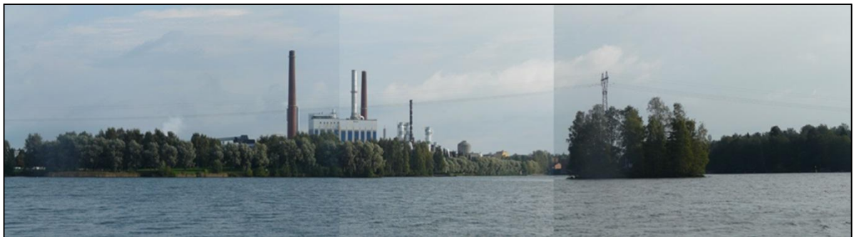
Kuva 16. Voimajohtoalue etelästä päin kuvattuna (kuvauspaikka 4). Maamerkkinä toimiva Valkeakosken voimalaitosalue näkyy puuston takana ja antaa maisemalle teollisen ilmeen. Nykyinen voimajohto kulkee vesistön poikki ilmaitse Voimajohtopylväs näkyy saaren takana ja muodostaa vertikaalin elementin voimalaitoksen korkeiden piippujen tavoin.
