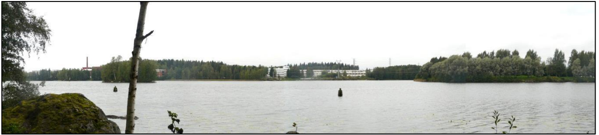
Kuva 19. Voimajohtoalue kuvattuna idästä tulevan voimajohdon alta. Voimalaitosaluetta ympäröivä kasvillisuus katkaisee voimakkaasti näkymiä voimalaitosalueelle. Uuden voimajohdon alta poistetaan puustoa.
