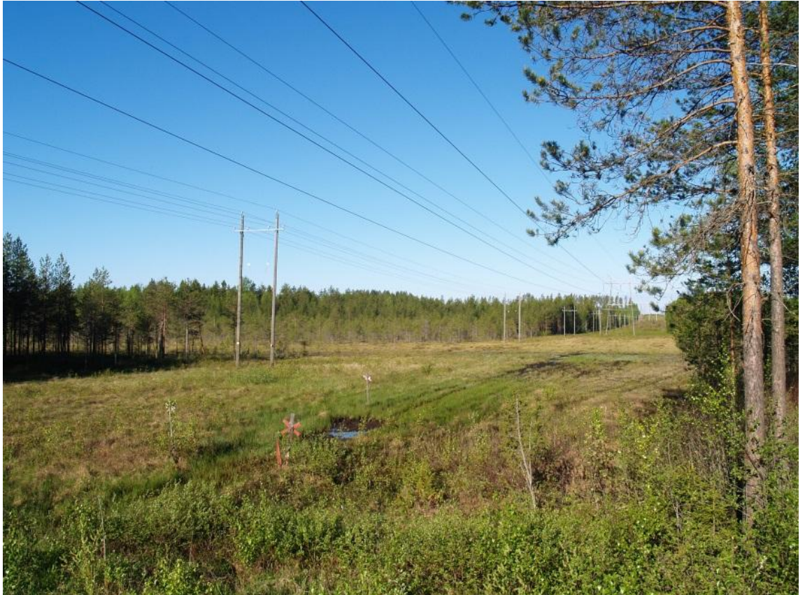
Kuva 5-4. Kuvassa voimajohtolinjaus sijoittuu avoimen suoalueen ylitse, Pieksämäen koillispuolella Mikkelintien kohdalla.
