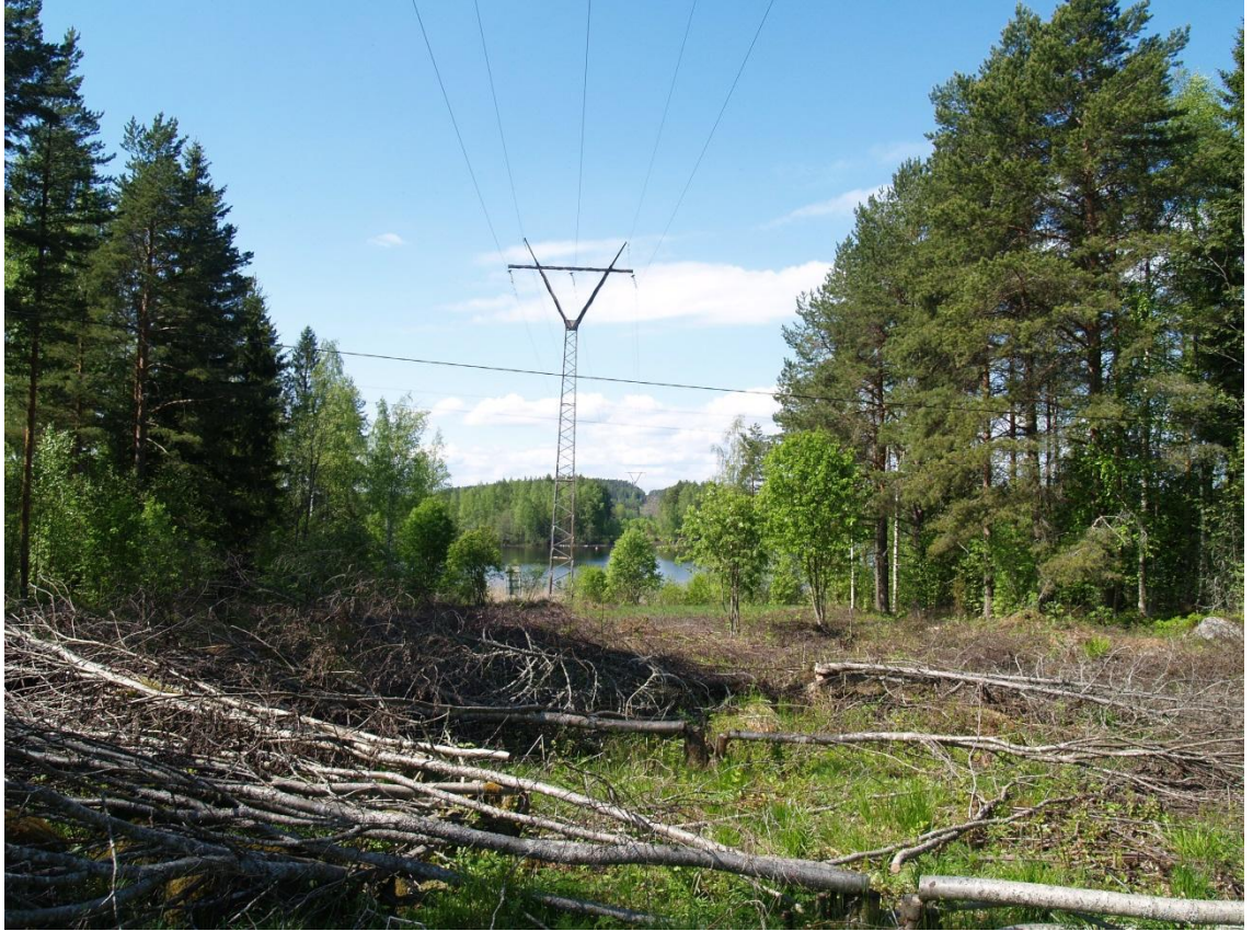
Kuva 4-2. Voimajohtolinja Jyväskylän Oravasaassa, kuvaussuunta länteen.
