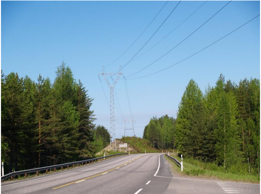
Kuva 5-2. Voimajohtolinjaus Pieksämäen länsipuolella kohdassa, jossa se ylittää valtatie 23.
