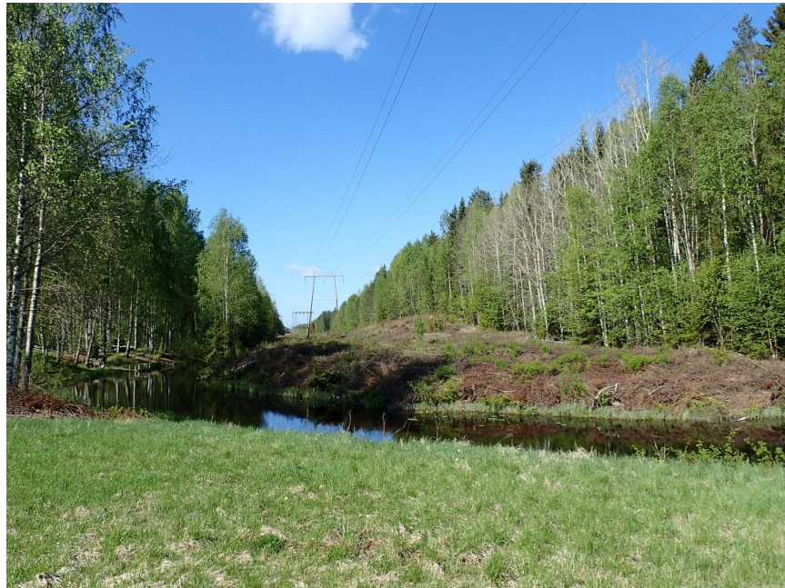
Kuva 6-14. Voimajohtoalue Hohonjoen ylityskohdalla.
