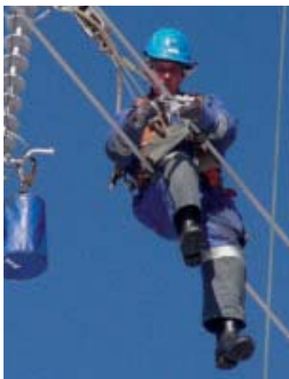
Johtimien sidontaa Varkaus–Huutokoski-työmaalla joulukuussa 2003. Työssä voima-johtoaesentaja Veli Ikonen.
