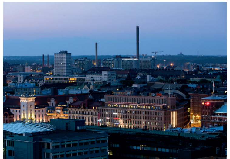
DCC-koodi käsittelee kulutuksen liittämistä sähköjärjestelmään. Kuvassa vasemmalla Äänekoskella rakenteilla oleva MetsäGroupin biotuotetehdas, oikealla Fingridin Tuovilan sähköasema.
