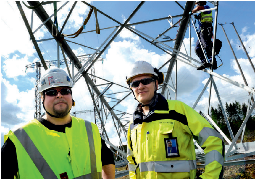
Työmaan valvoja Ossi Muuronen (vas.) ja pääurakoitsija Vattenfallin turvallisuusvalvoja Jaakko Hämäläinen tarkastavat linjatyömaan työturvallisuusasioita Kouvolan Kiehuvasa.
