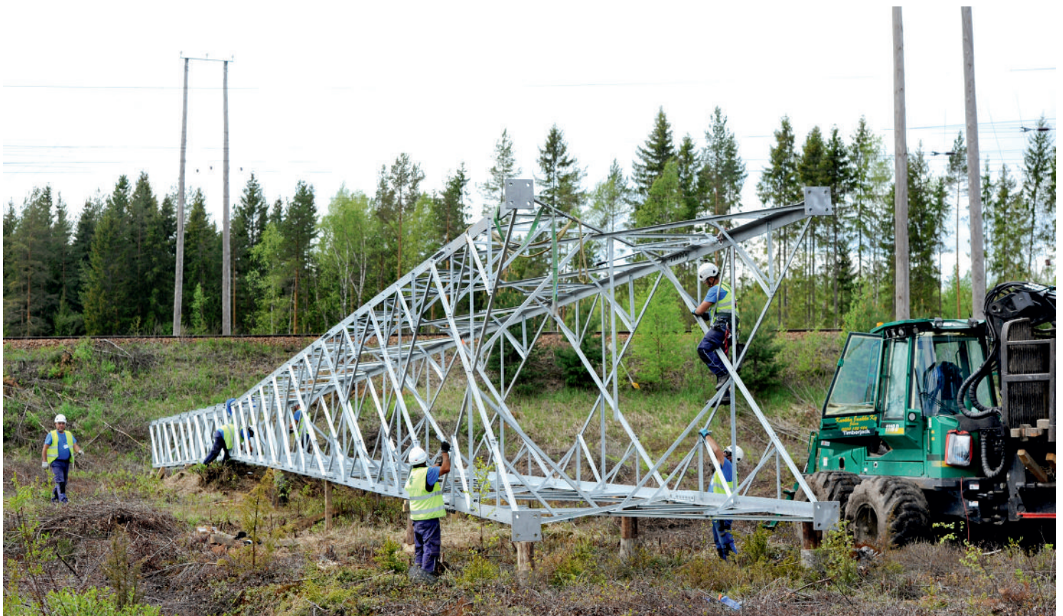
Portugalilainen työntekijäryhmä työskentelee linjatyömaalla Kouvolan Kiehuvasa. Työmaan turvallisuusperehdytyksessä apuna on ollut Fingridin verkkokoulu.
