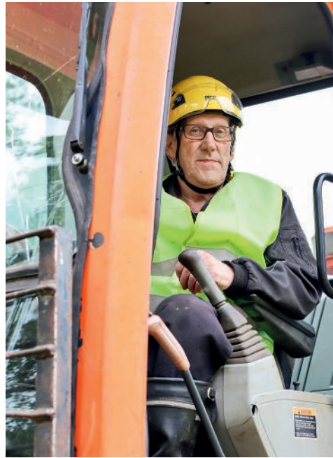
Kaivinkonekuljettajat Ville Juntunen ja Pekka Kolehmainen siirtelivät maata varovasti kaivinkoneillaan. Hiilimiilun löytyminen omilta mailta oli Kolehmaiselle todellinen yllätys.
