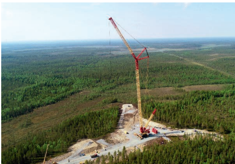
lin Viinämäkeen nousevat Suomen korkeimmat tuuliturbiinit. Niiden napakorkeus tulee olemaan 175 metriä ja roottorihalkaisija 150 metriä.
