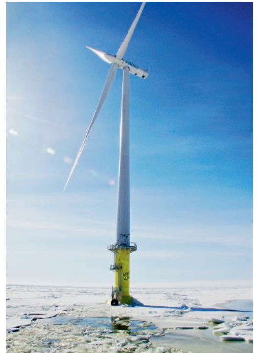
Suomen ensimmäinen merituulipuisto Porin Tahkoluodossa on maailman ensimmäinen arktinen merituulipuisto. Kymmenen vuonna 2017 pystytetyn voimalan napakorkeus on 90 metriä ja roottorihalkaisija 130 metriä.
