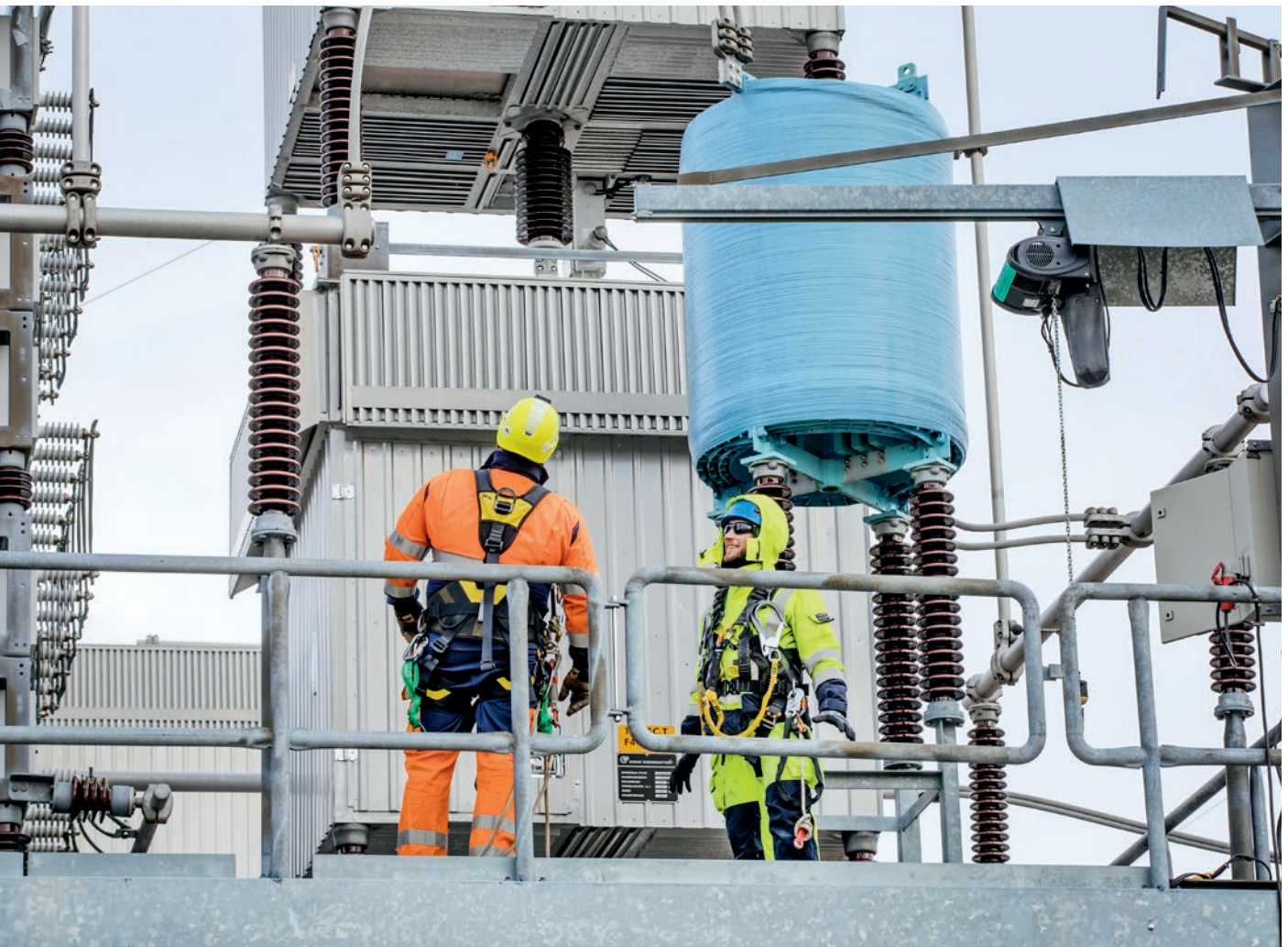
Keminmaan sähköaseman koekiipeäminen käsitti sarjakondensaattorin lavalle kiipeämisen ja siellä työskentelyn.
