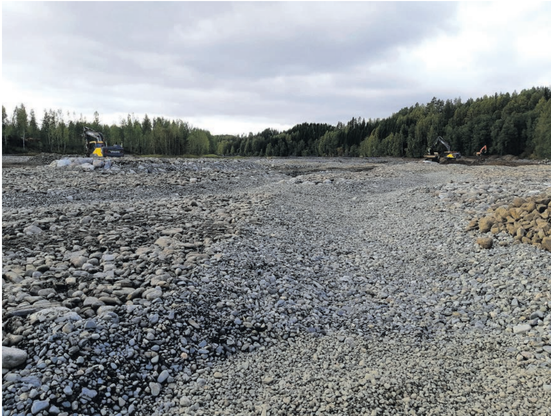
Laurinvirtana tunnettuun tulvauomaan on rakennettu mittava järvilohelle soveltuva lisääntymis- ja poikasalue. Tätä varten on kuivattu lähes kymmenen hehtaaria vanhaa, soistunutta jokiuomaa.
