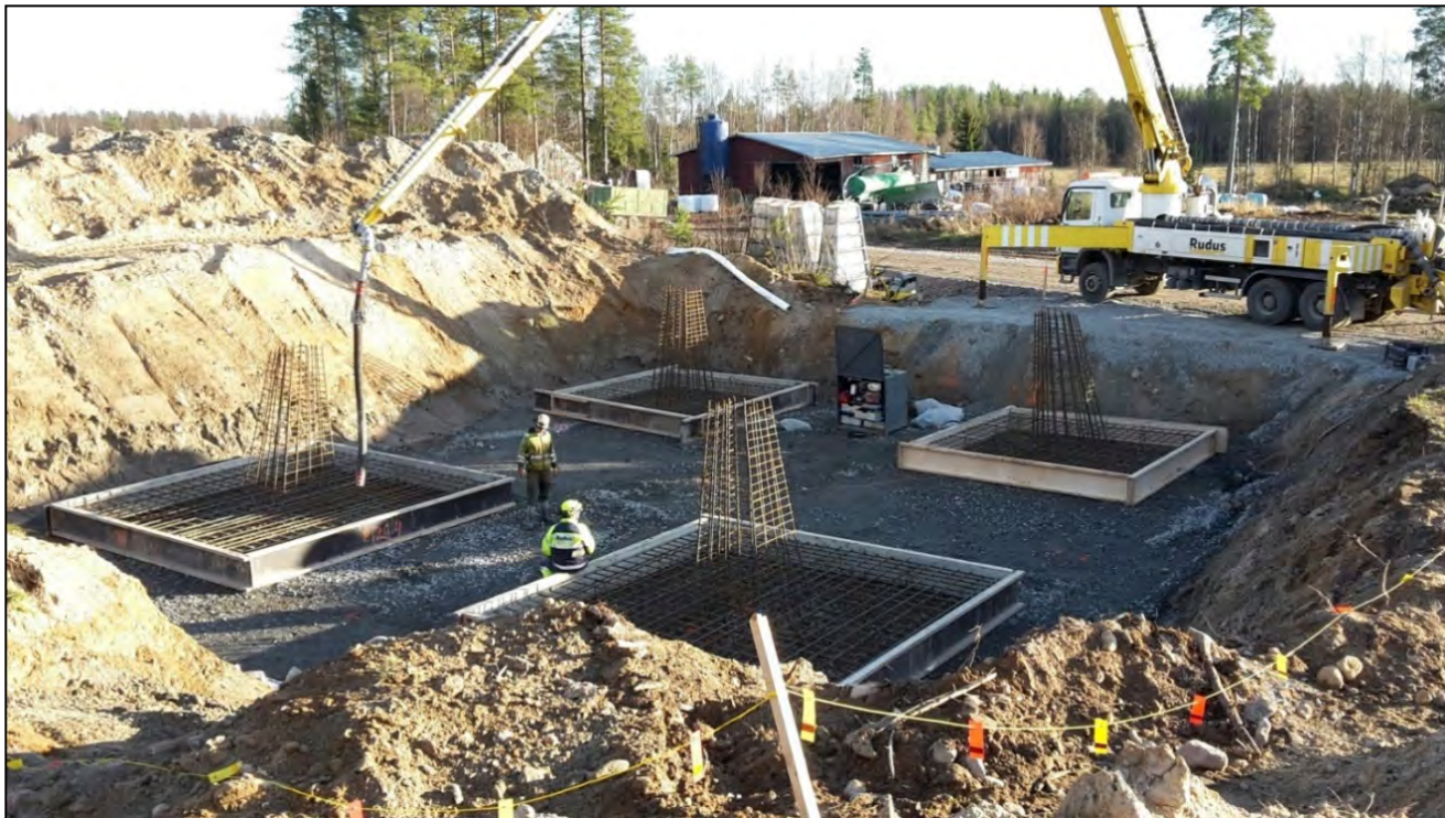
Kuva 2-5. Vapaasti seisovan pylvään perustuksen pohjatöitä.
