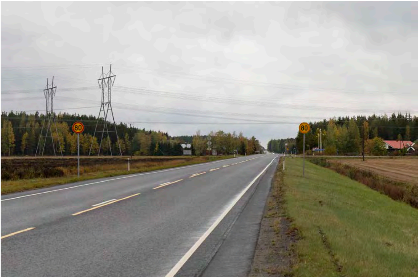
Kuva 7-13 (kuvauspaikka D). Kuva Turuntieltä, Valtatie 9, Niinimäen kohdalta kohti osuutta O-P (objektiivin 35mm). Kuvassa lähempänä näkyy uusi 400 kilovoltin voimajohto ja kauempana nykyinen siirretty 400 kilovoltin voimajohto.
