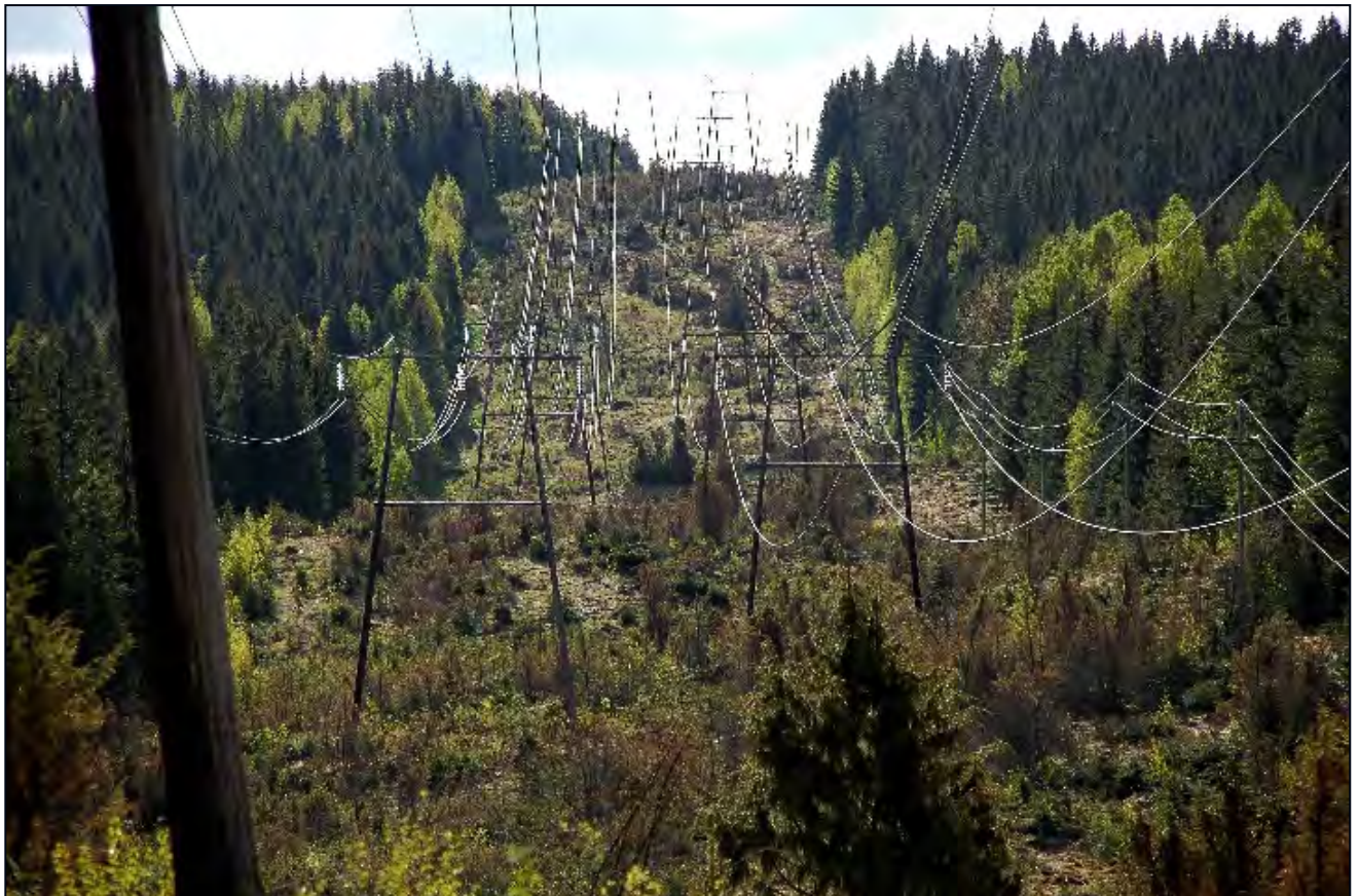
Kuva 2-7. Esimerkki valikoivasta raivauksesta.
