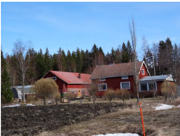
Kuva 8-13. Asuinrakennus Ohrapellossa noin 40 metrin etäisyydellä suunnitellun voimajohdon keskilinjasta, johtoalueen ulkopuolella.
