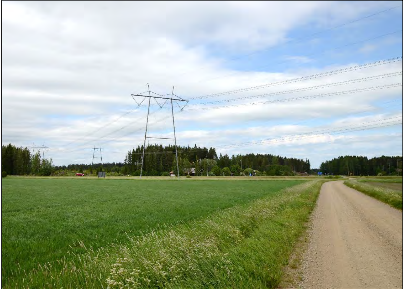
Kuva 7-3. Nykyiset 400 ja 110 kilovoltin voimajohdon Huittisten Niinimäessä (taustalla valtatie 9).
