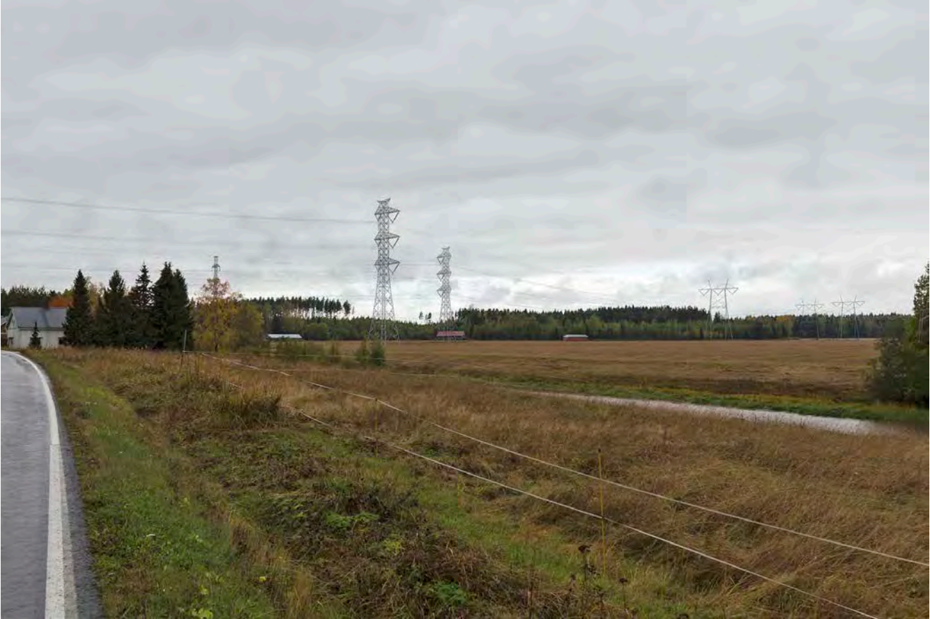
Kuva 7-17 (kuvauspaikka F). Näkymä Leimukallion kohdalta vanhatieltä länteen. Kuvassa näkyy S-Ta ja S-Tb voimajohdot (objektiivin 35 mm).
