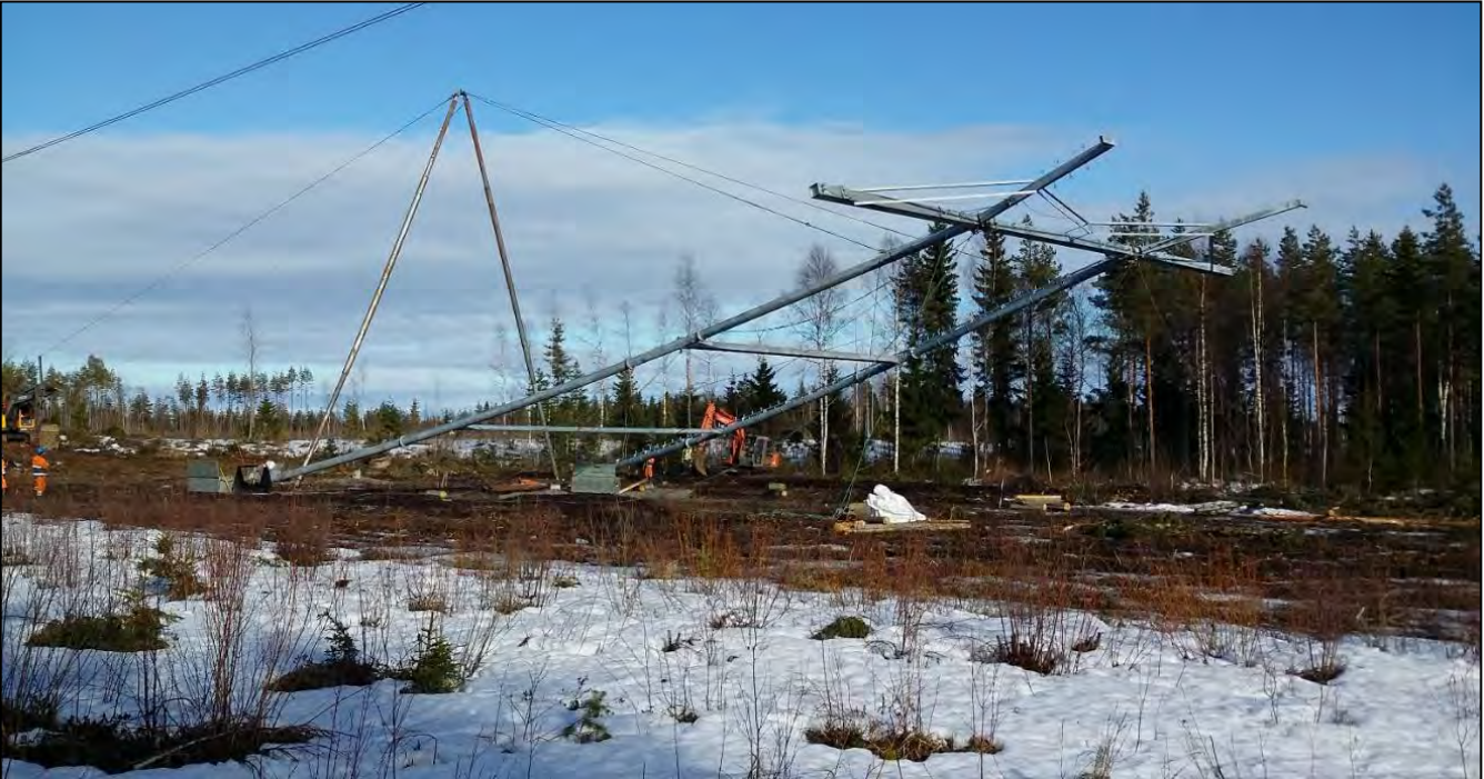
Kuva 2-6. Voimajohtopylvään pystytys.
