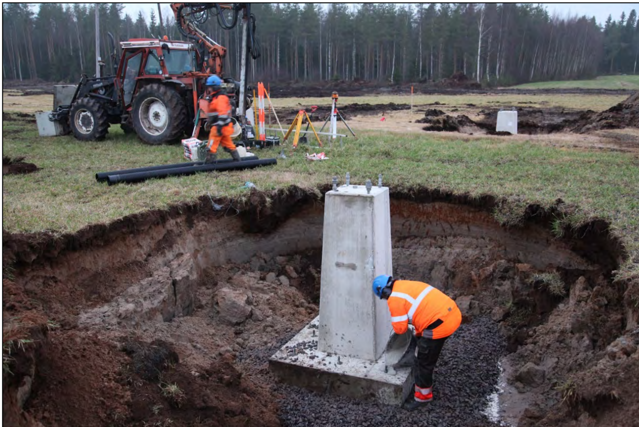
Kuva 2-4. Pylvään perustuselementin asentaminen.
