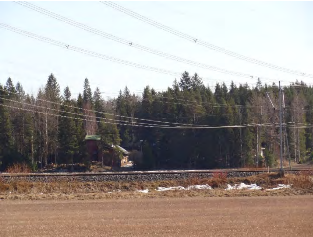
Kuva 8-16. Voimajohdon reunavyöhykkeelle sijoittuva asuinrakennus Isänmaassa.
