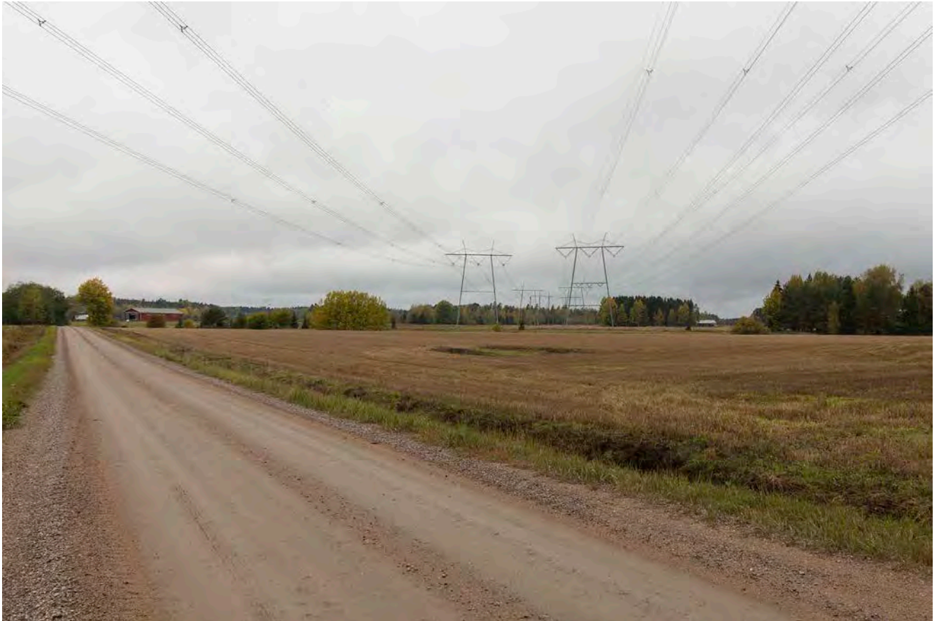
Kuva 7-12 (kuvauspaikka C). Näkymä Mäki-Uotilan kohdalta pohjoiseen. Kuvassa uusi johto L-M on oikeanpuoleinen voimajohto, jonka oikealla puolella näkyy siirretyn 110 kilovoltin voimajohtojen johtoalue (objektiivin 35 mm).
