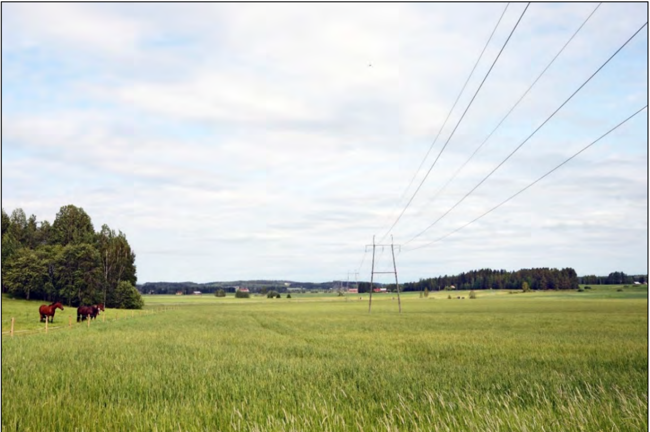
Kuva 7-2. Nykyinen 110 kilovoltin voimajohto Jokioisten Savikon peltomaisemassa.
