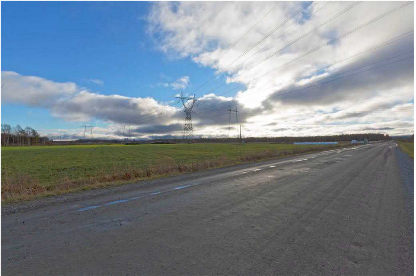
Kuva 8-12. Havainnekuva E näkymä Vuolijoen eteläpuoleiselta pellolta (objektiivivi 16 mm). Uusi voimajohto näkyy vasemmanpuoleisena. Kuvan keskellä näkyy uuden voimajohdon Y-tyyppinen pylvääs.
