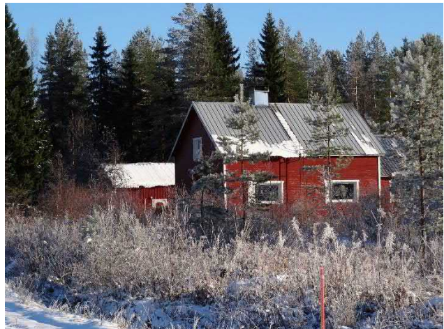
Kuva 7-17. Asuinrakennus Rinteelässä noin 29 metrin etäisyydellä suunnitellun voimajohdon keskilinjasta sen reunavyöhykkeellä.
