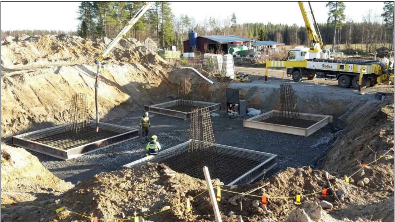
Kuva 2-5. Vapaasti seisovan pylvään perustuksen pohjatöitä.
