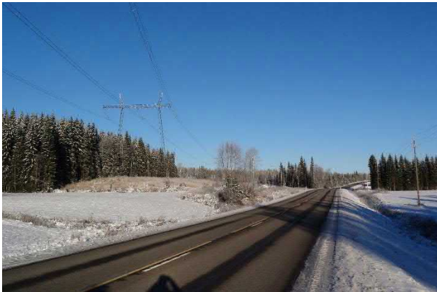
Kuva 7-25. Voimajohdon risteäminen valtatie 5 kanssa Sonkajärvellä.
