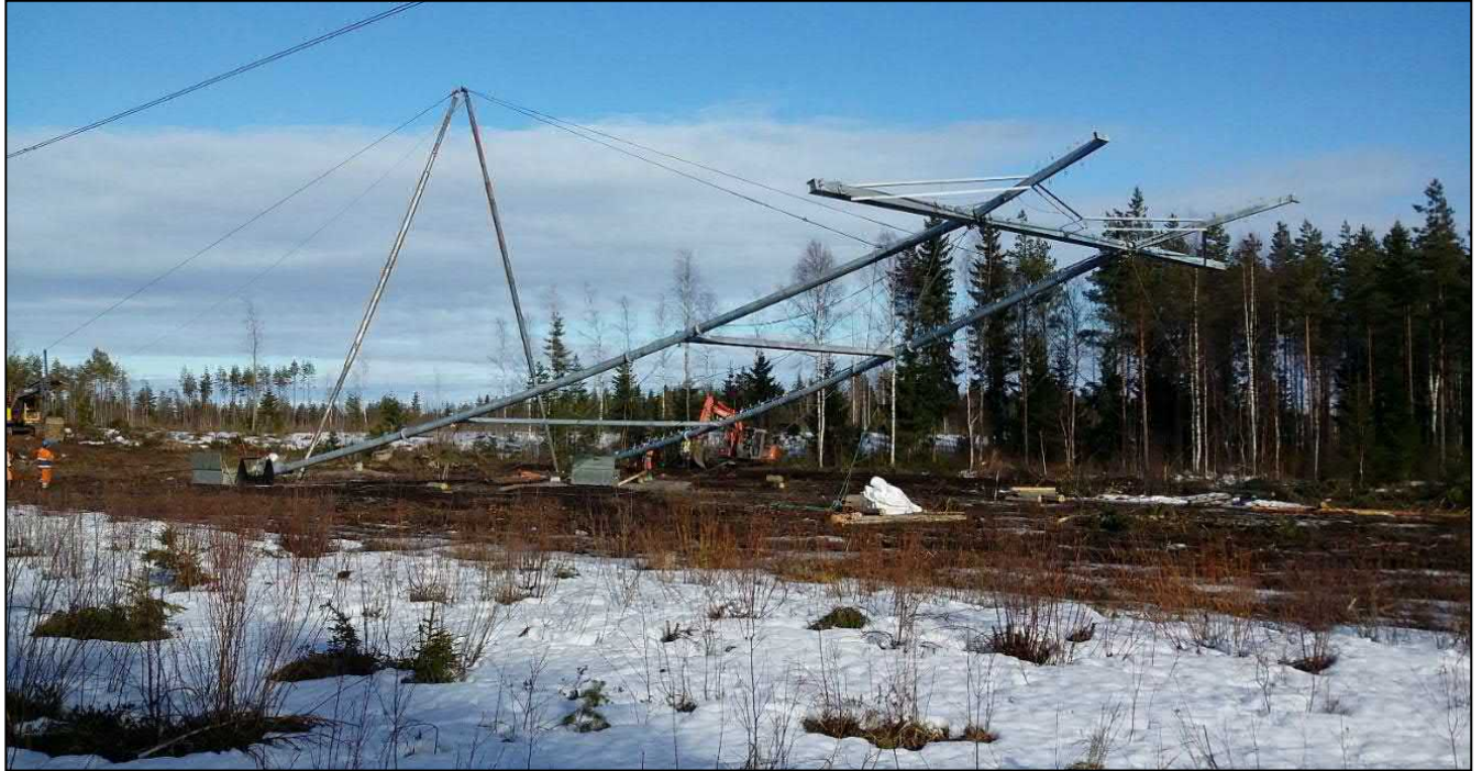
Kuva 2-6. Voimajohtopylvään pystytys.
