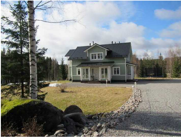
Kuva 7-19. Asuinrakennus Alapitkän sähköaseman suunnittelualueella.
