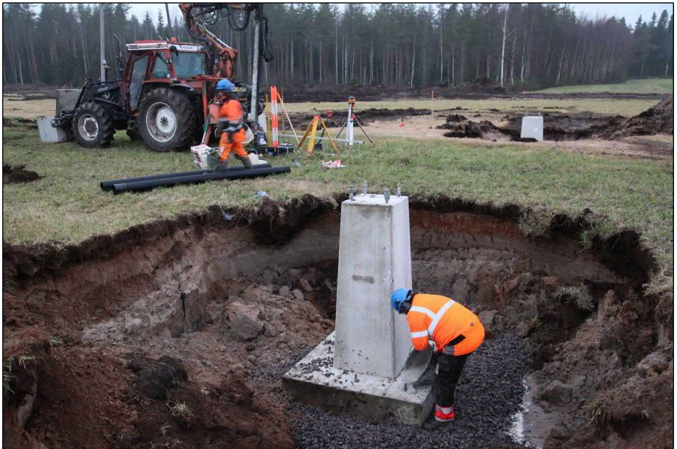
Kuva 2-4. Pylvään perustuselementin asentaminen.
