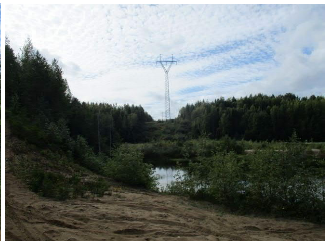
Linjaus sorakuopan kohdalla
