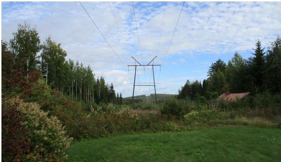
Eerolan kylän eteläisin talo sijaitsee voimalinjan tuntumassa.
