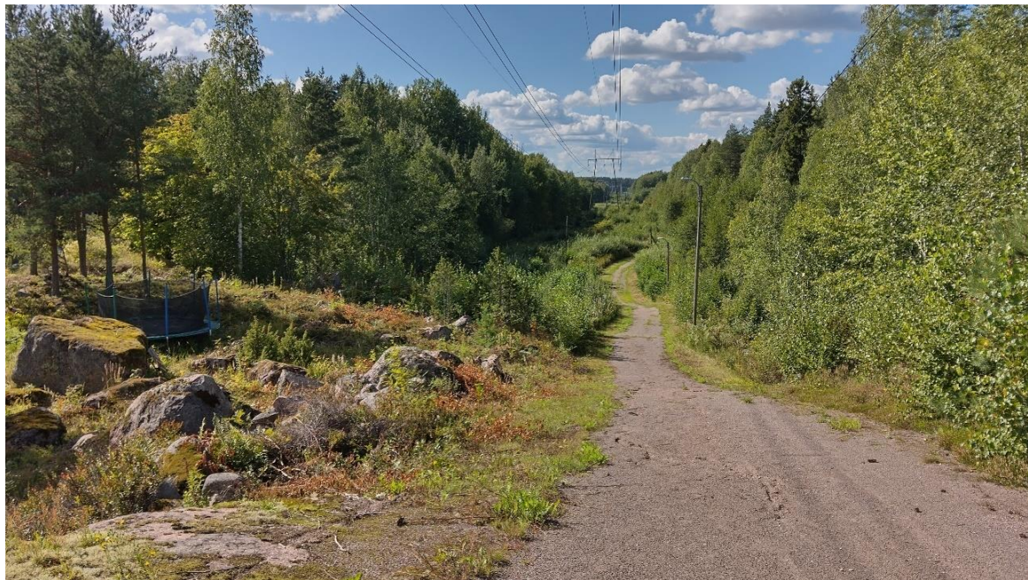
Kuva 6-14. Kuvauspaikka 7.2: Näkymää Ulrikan asuinalueen Wredentien asutuksen takaa, purettavan voimajohdon viereseltä kuntopolulta länteen. Kuvassa näkyy Skogbackan purettava voimajohto.
