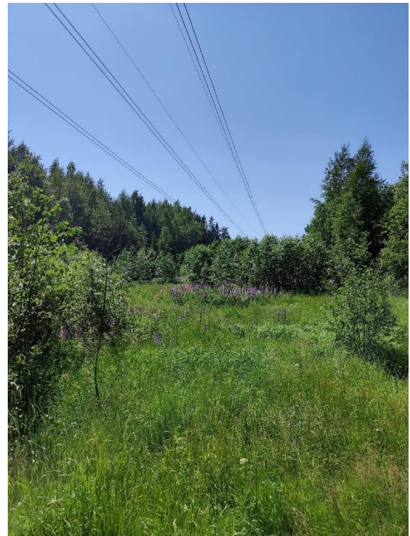
Kuva 33 Johtoaukean kasvillisuus on heinävaltaista
