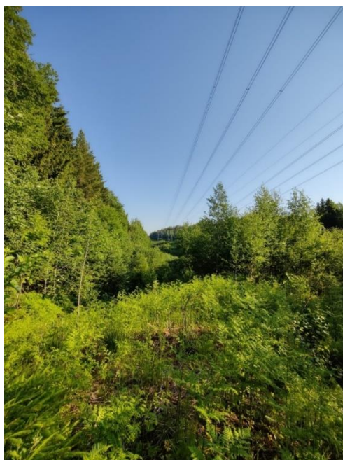
Kuva 20 Johtoalue Myllymäen alueen alkupäässä.
