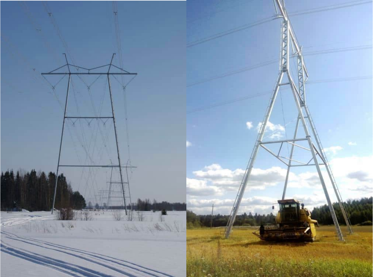
Kuva 4.19. Esimerkkikuvat eri pylvästyypeistä. Vasemmalla perusratkaisun mukainen 400+110 kilovoltin haruksin tuettu portaalipylväs ja oikealla vapaasti seisova harukseton peltopylväs.
