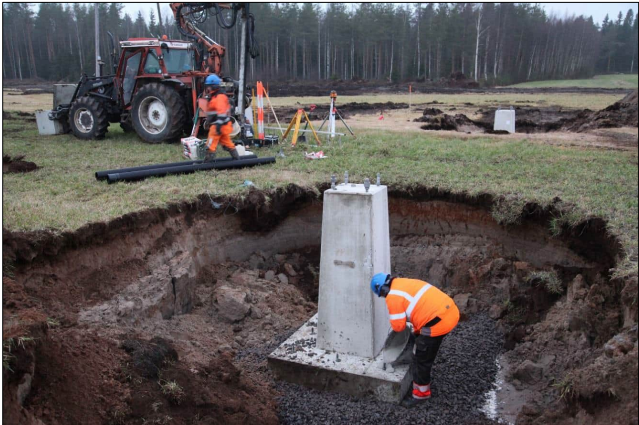
Kuva 3.4. Pylvään perustuselementin asentaminen.
