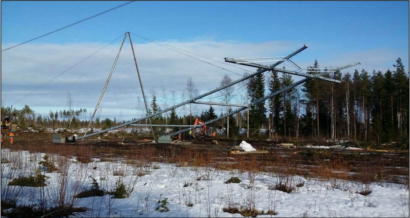
Kuva 3.6. Voimajohtopylvään pystytys.
