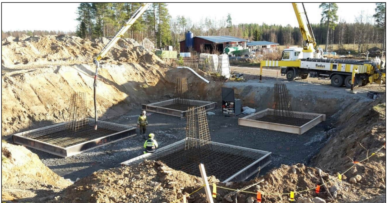
Kuva 3.5. Vapaasti seisovan pylvään perustuksen pohjatöitä.
