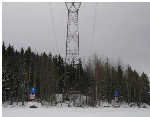
Kuva 9. Laivaväylätaulut ja liian korkea puustoa erikoiskohteessa
