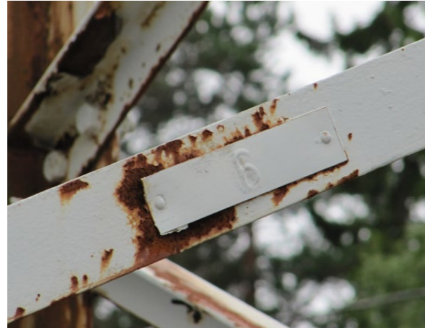
Kuva 5. Metallilevyyn painettu pylväsnumero
