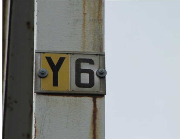
Kuva 4. Numerokylttiin kiinnitetty pylväsnumero
