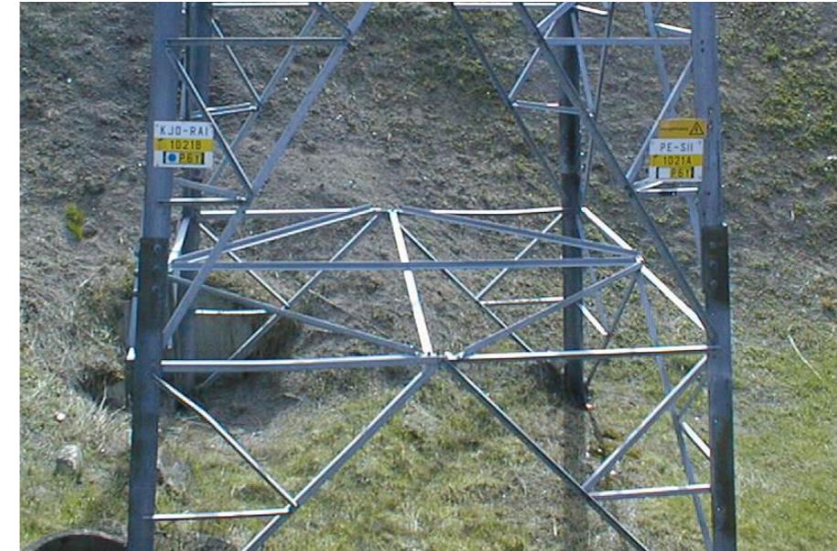
Kuva 7. Pylvästunnistekilvet kahden virtapiirin pylväällä
