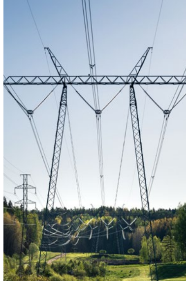
400 kV harustettu pylväs
