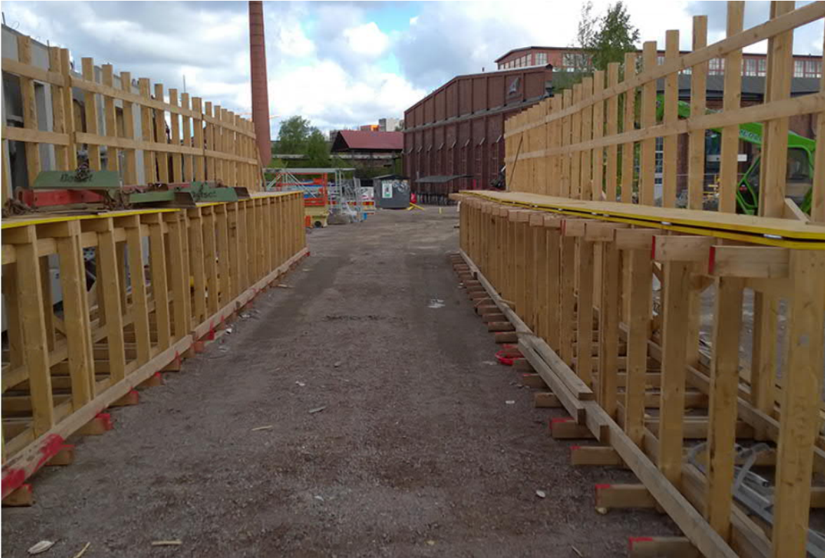
Kuva elementtikuorman purkutyöstä, jossa työntekijän putoaminen on estetty telineillä.
