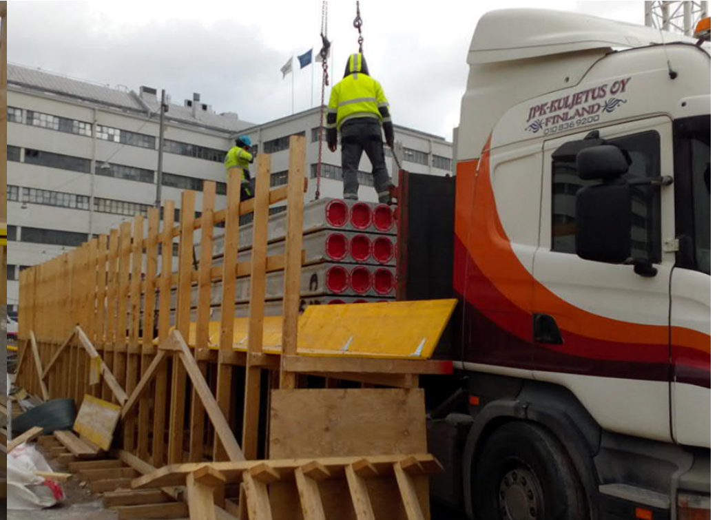
Kuva elementtikuorman purkutyöstä, jossa työntekijän putoaminen on estetty telineillä.
