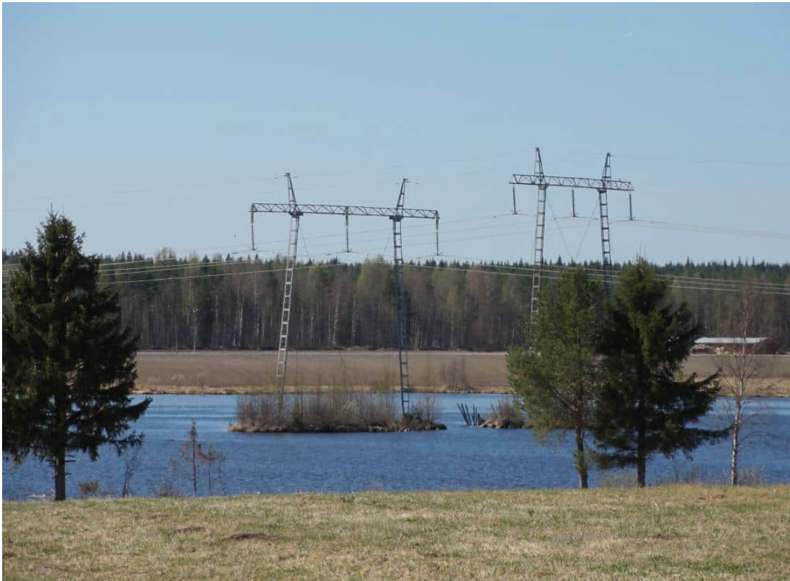
Kuva 3.7. Tekoluodolle rakennettu nykyinen voimajohtopylväs Haapajärven Kortejärvellä.
