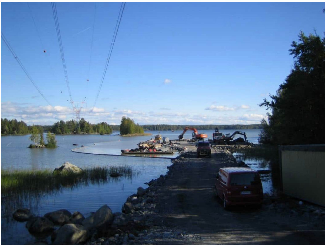
Kuva 3.8. Lähellä rantaa sijaitsevan vesistöpylvään rakentaminen vaatii yleensä väliaikaisen tieyhteyden.
