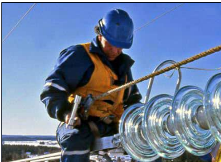
Kuva 6-5. Voimajohtopylvään eristimiä, joissa koronapurkauksia voi esiintyä.
