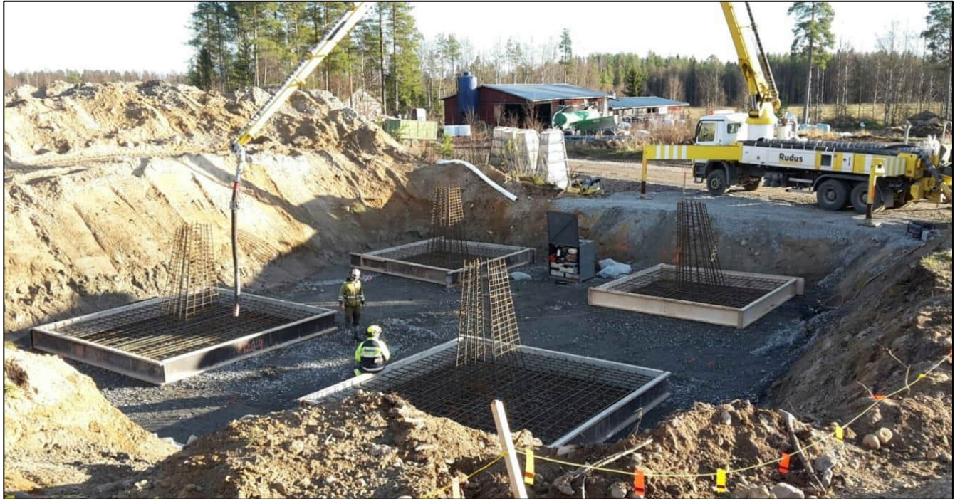
Kuva 3.5. Vapaasti seisovan pylvään perustuksen pohjatöitä.
