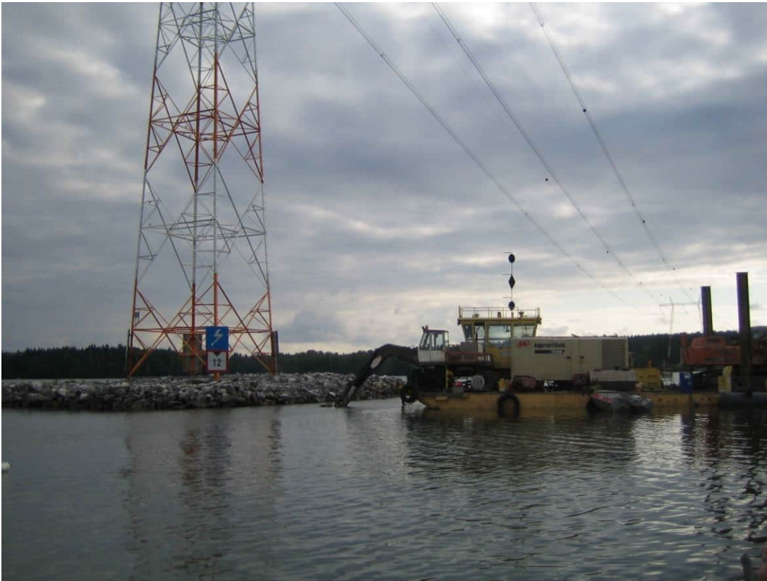
Kuva 3.9. Vapaasti seisovan pylvään tekoluodon reunaluiskojen viimeistelyä Pyhäjärvellä Pirkkalassa.
