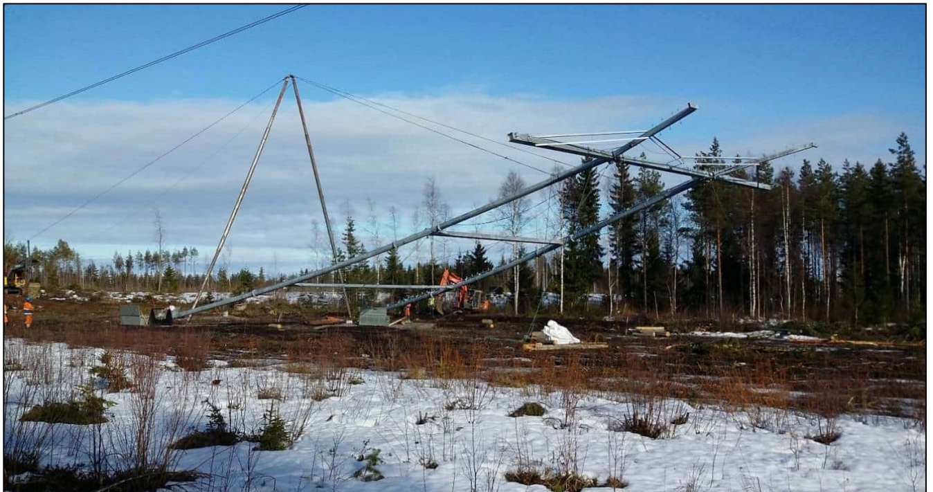
Kuva 3.6. Voimajohtopylvään pystytys.
