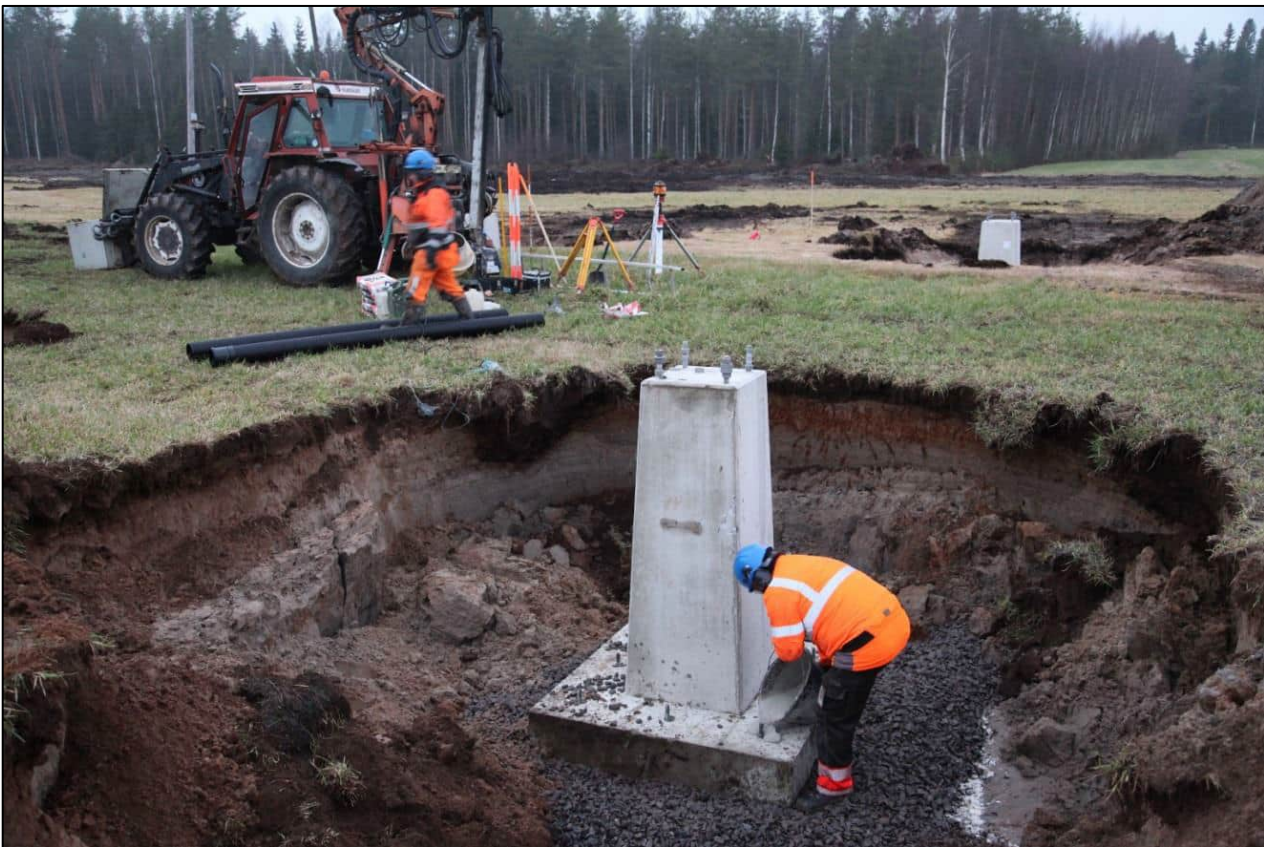
Kuva 3.4. Pylvään perustuselementin asentaminen.
