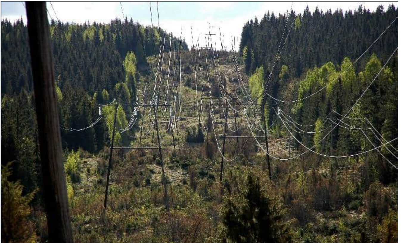
Kuva 3.11. Esimerkki valikoivasta raivauksesta.
