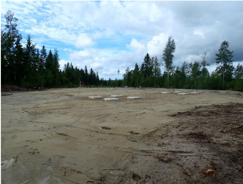
Kuva 6-28. Suunnitellun voimajohdon pohjoispäähän (Furubacka) oli jo rakennettu perustuksia.
