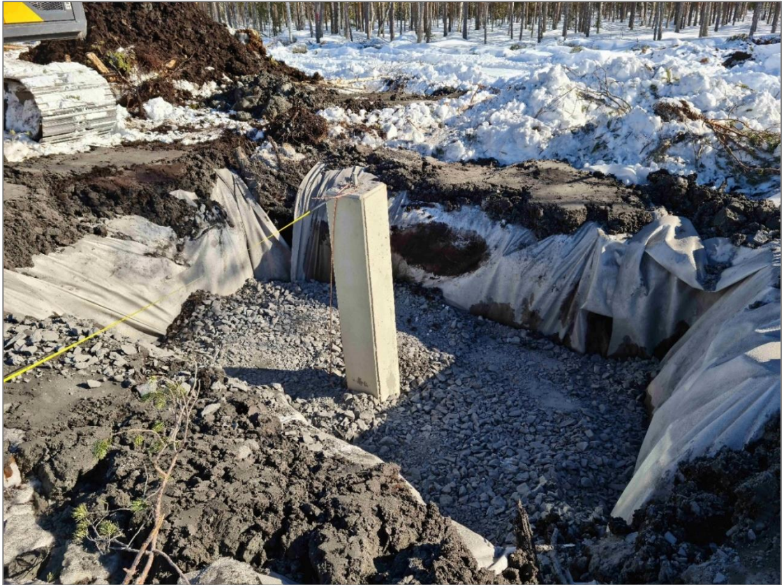
Kuva 3-4. Pylvään perustuselementin asentaminen. Bild 3-4. Installering av stolpfundament.
