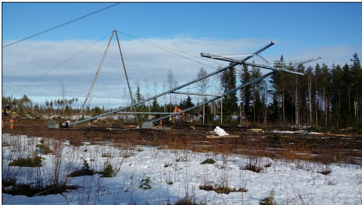
Kuva 3-7. Voimajohtopylvään pystytys. Bild 3-7. Resning av en kraftledningsstolpe.
