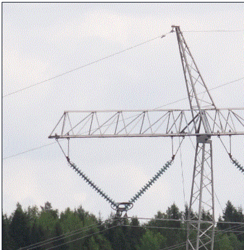
Kuva 6-6. Voimajohtopylvään eristimiä, joissa koronapurkauksia voi esiintyä. Bild 6-6. Isolerade delar av kraftledningsstolpar i vilka det kan förekomma koronaurldningar.
