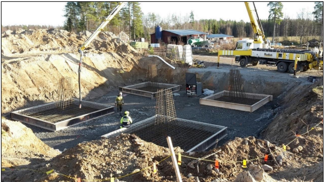
Kuva 3-5. Vapaasti seisovan pylvään perustuksen pohjatöitä. Bild 3-5. Grundläggande arbete för en fristående stolpes fundament.
