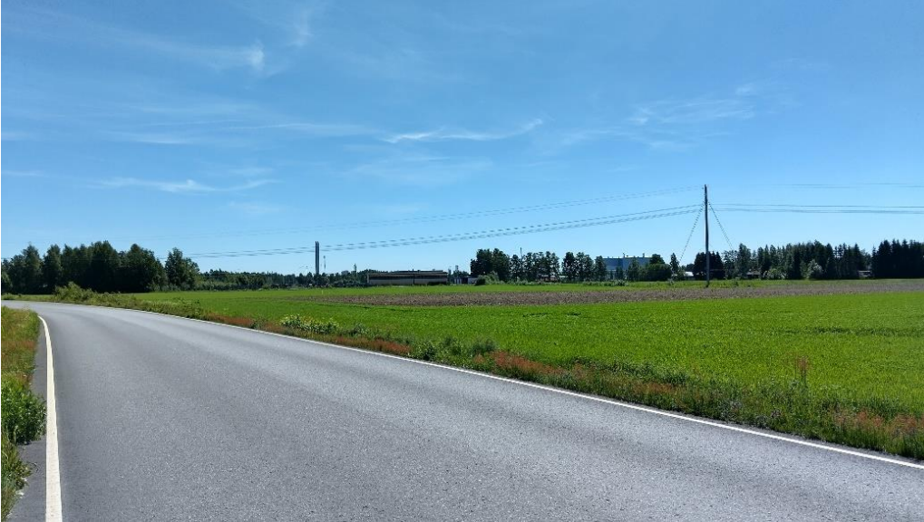
Kuva 6-12. Kuvauspaikka 6: Näkymää peltoaukean yli, Harjavallantieltä kaakkoon. Kuvassa näkyy Caruna Oy:n 110 kilovoltin Impola-Harjavalta voimajohto. Suunniteltu voimajohto sijoittuisi kuvassa näkyvän nykyisen johdon eteläpuolelle eli kuvassa sen taakse.
