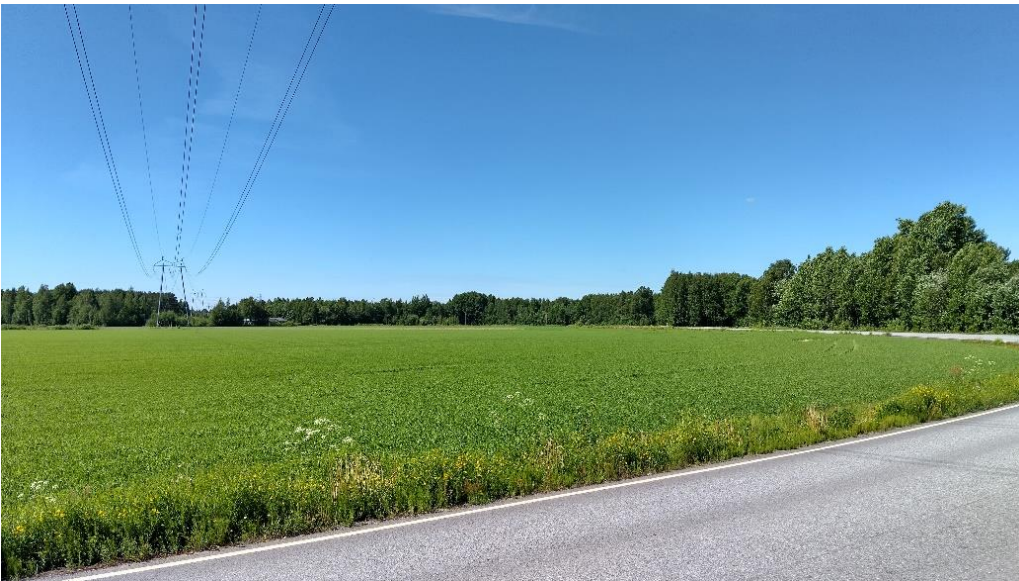
Kuva 6-13 Kuvauspaikka 7.1: Näkymä Harjavallantieltä luoteis-länsisuuntaan. Kuvassa näkyy Caruna Oy:n 110 kilovoltin Impola-Harjavalta voimajohto. Suunniteltu voimajohto sijoittuisi kuvassa näkyvän nykyisen johdon eteläpuolelle eli kuvassa sen vasemmalle puolelle. Hankkeen myötä eteläpuolelta puusto raivataan 20 metrin vyöhykkeeltä, jolloin taustalla näkyvä johtokäytävä levenee.
