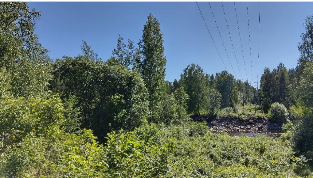
Kuva 6-7. Kuvauspaikka 2: Padon jälkeinen avoin johtoaukea, jossa näkyy jakeluverkon keskijänniteilmajohto. Kuvauspaikalta ei ole selkeää näkymää suunnitellulle Kissakuja-Harjavalta 110 kilovoltin voimajohdolle.
