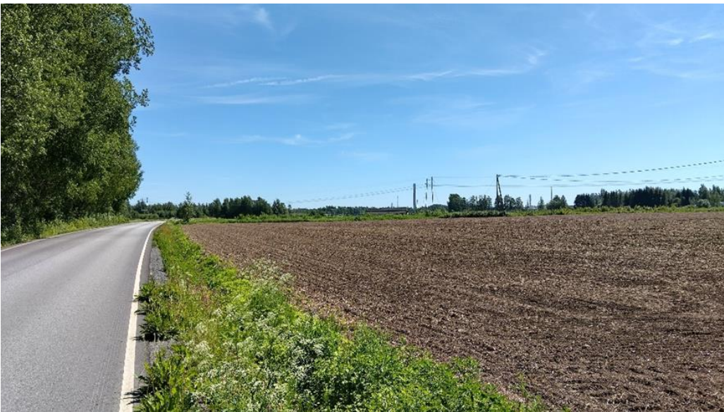
Kuva 6-11. Kuvauspaikka 5: Näkymää peltoaukean yli, Harjavallantieltä kaakkoon. Kuvassa näkyy Caruna Oy:n 110 kilovoltin Impola-Harjavalta voimajohto. Suunniteltu voimajohto sijoittuisi kuvassa näkyvän nykyisen johdon eteläpuolelle eli kuvassa sen taakse.
