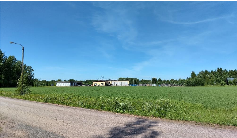
Kuva 6-21. Kuvaspaikka 10: Näkymää Kissakujan itäosasta kohti luodetta, peltoaukeiden yli. Kuvassa etualalla näkyy varistorakennuksia ja taustalla Caruna Oy:n 110 kilovoltin Impola-Harjavalta voimajohto. Suunniteltu voimajohto sijoittuisi kuvassa näkyvän nykyisen johdon eteläpuolelle eli kuvassa sen eteen.
