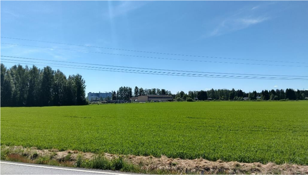
Kuva 6-14. Kuvauspaikka 7.2: Näkymä Harjavallantieltä lounaaseen. Kuvassa näkyy Caruna Oy:n 110 kilovoltin Impola-Harjavalta voimajohto. Suunniteltu voimajohto sijoittuisi kuvassa näkyvän nykyisen johdon eteläpuolelle eli kuvassa sen taakse. Taustalla näkyvät metsäalueet jäävät levenevän johtoalueen ulkopuolelle ja säilyvät entisellään.
