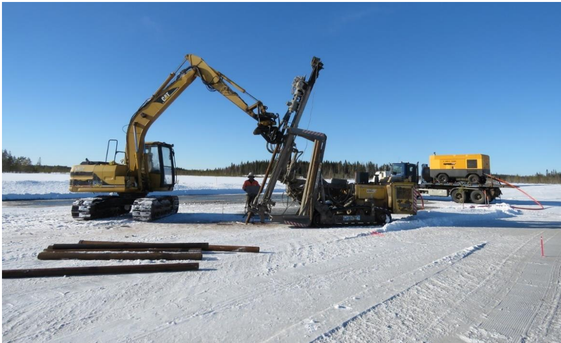
Kuva 19. Arvokkaalla luontokohteella, kuten suolla, työalue voidaan jäädyttää tarvittaessa ennen asennustöitä. Kuva: Fingrid.
