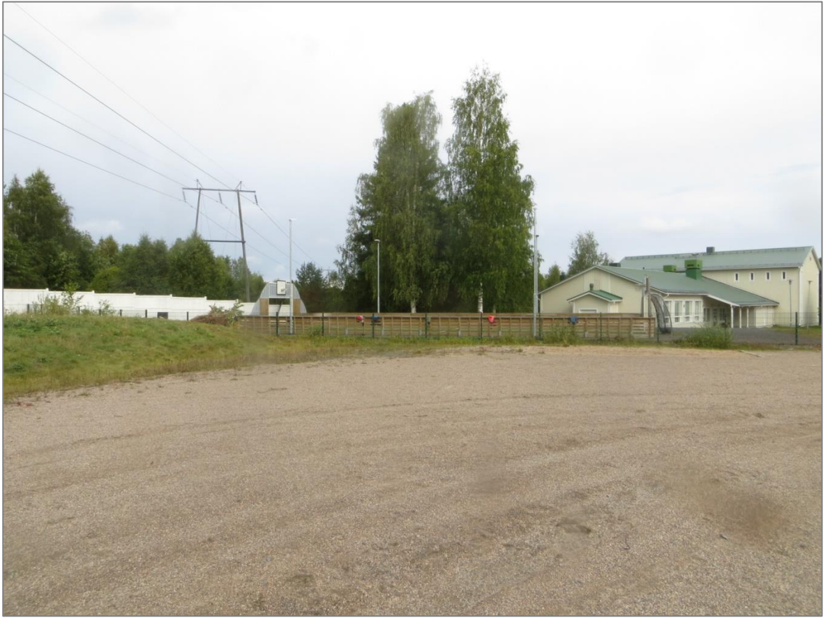
Kuva 4-6. Voimajohtoreitti sivuaa Alakylän koulua (kuvaussuunta pohjoiseen). Uusi voimajohto suunnitellaan rakennettavaksi nykyisen voimajohdon kanssa yhteispylväeseen nykyiseen maastokäytävään. Yhteispylväs on nykyistä pylväsmallia korkeampi.
