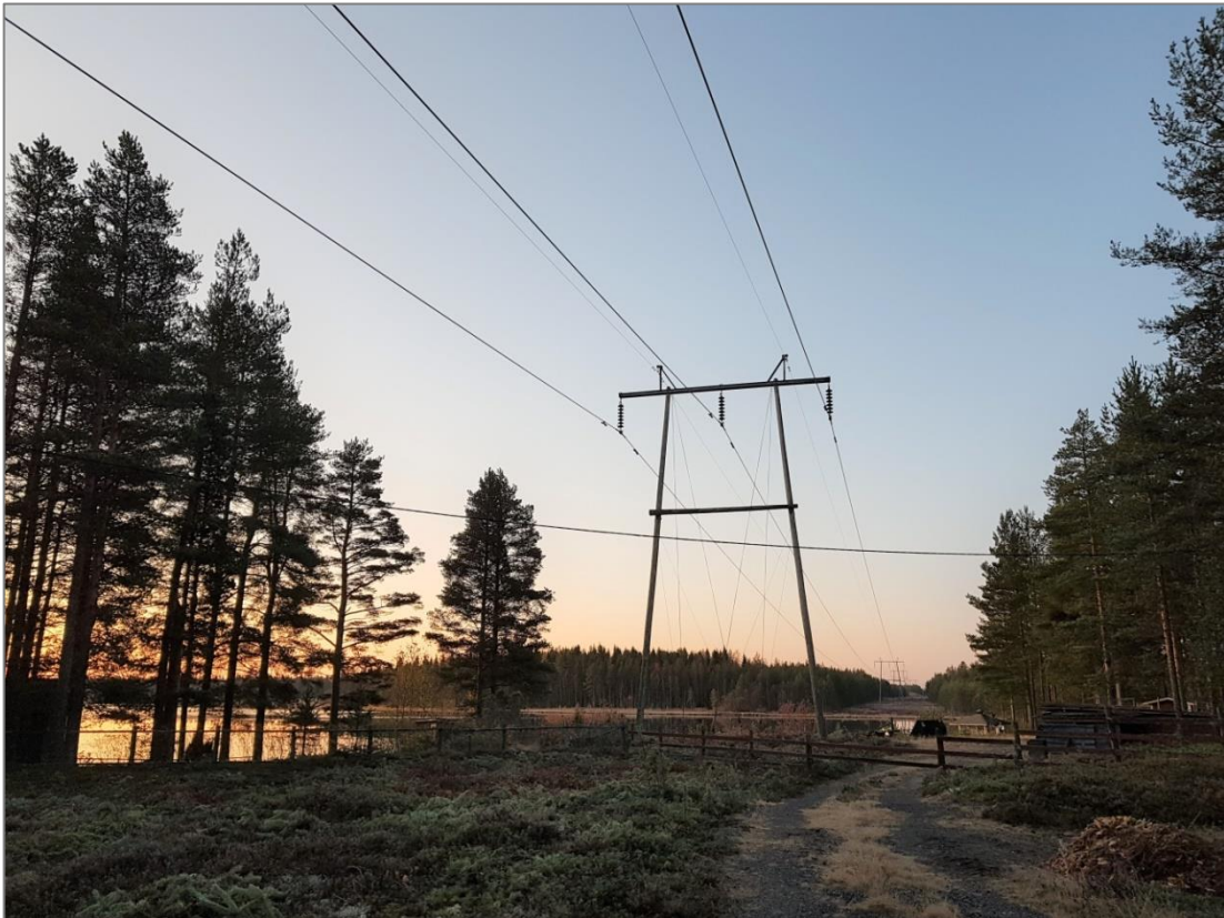
Kuva 4-9. Alakylällä Nurmijärven pohjoisrannalla on vakituista ja vapaa-ajanasutusta (kuvaussuunta etelään, katso. maisemasovite liitteessä 4).
