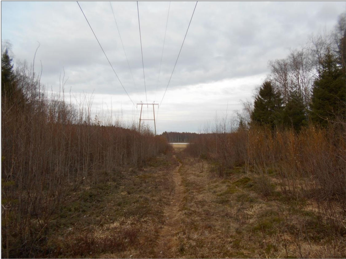
Kuva 5-3. Kalikkalammen kiertävä hiihtolatu hyödyntää myös voimajohtoaluetta (kuvaussuunta kaakkoon, suunniteltu voimajohtoreitti sijoittuu nykyisen voimajohdon oikealle puolelle).
