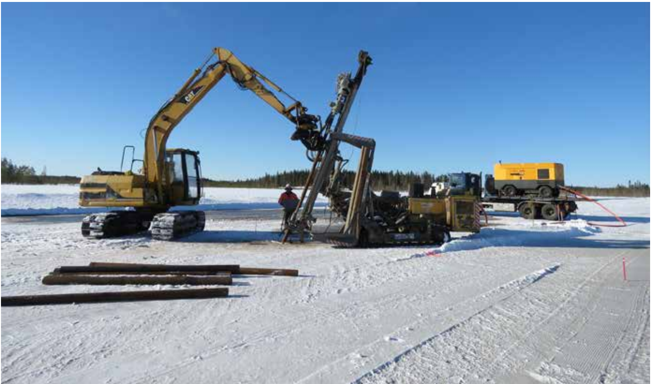
Kuva 6. Porapaaluperustuksen tekoa suoalueella, missä työalue on jäädytetty.
