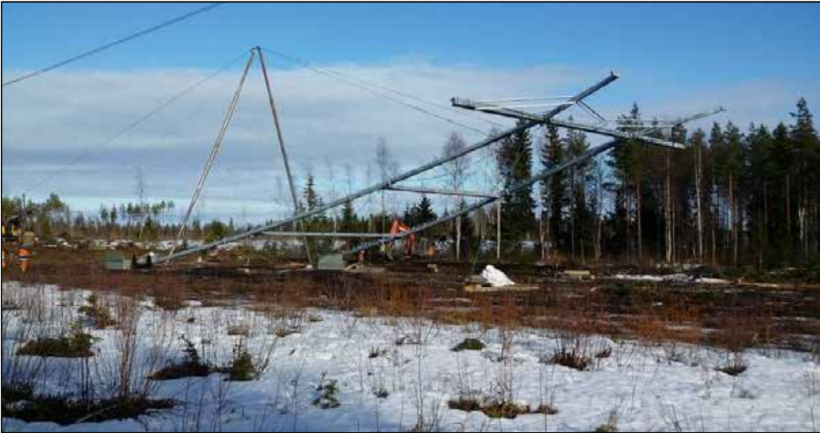
Kuva 7. Voimajohtopylvään pystytys.
