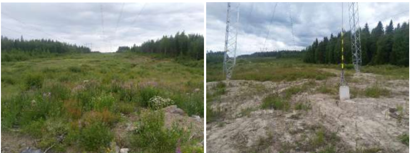
Kuva 123. Lämäkankaan kumpumoreenialueelle rakennettu Metsälinjan uusi voimajohto valmistui 2022. Rakentamisesta aiheutuneet muutokset ovat vähäisiä ja selvimminkin havaittavissa pylväspaikoilla.
