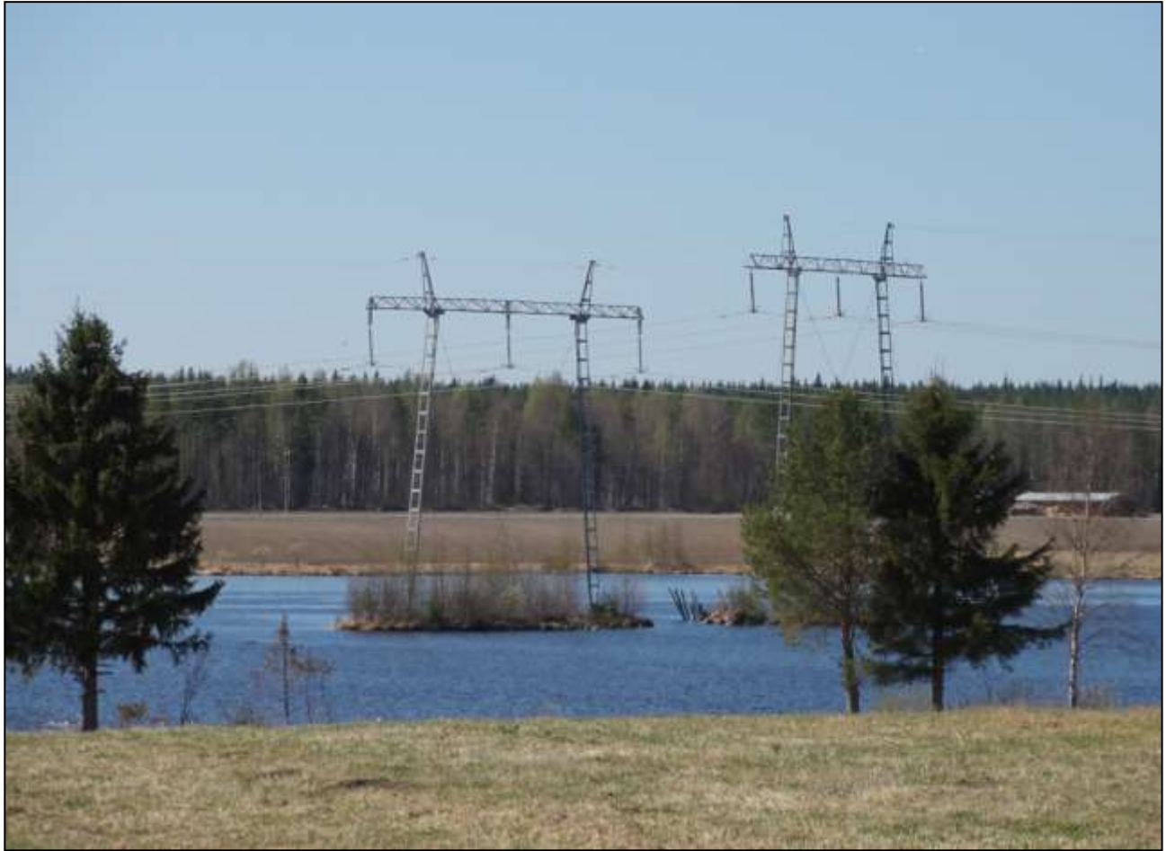
Kuva 13. Tekoluodolle rakennetut nykyiset voimajohtopylväät Haapajärven Kortejärvellä.
