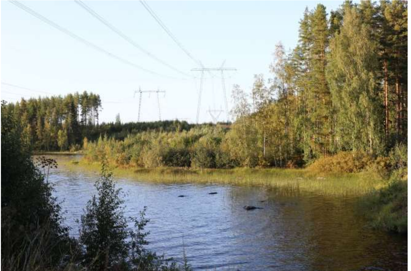
Kuva 100. Kivijärven Hannonsalmen tuntumassa sijaitseva johtokäytävä nykytilassa.
