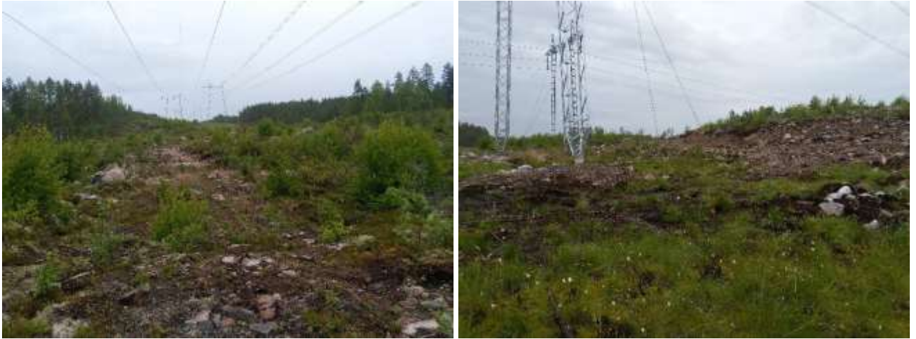
Kuva 125. Pienen Kotavaaran kumpumoreenialueella voimajohdon rakentamisesta vanhan paikalle jää jälkiä pylväspaikoille sekä ajourille. Muutokset ovat paikallisia ja ympäristö on osittain aiemmin jo häiriytynyttä.
