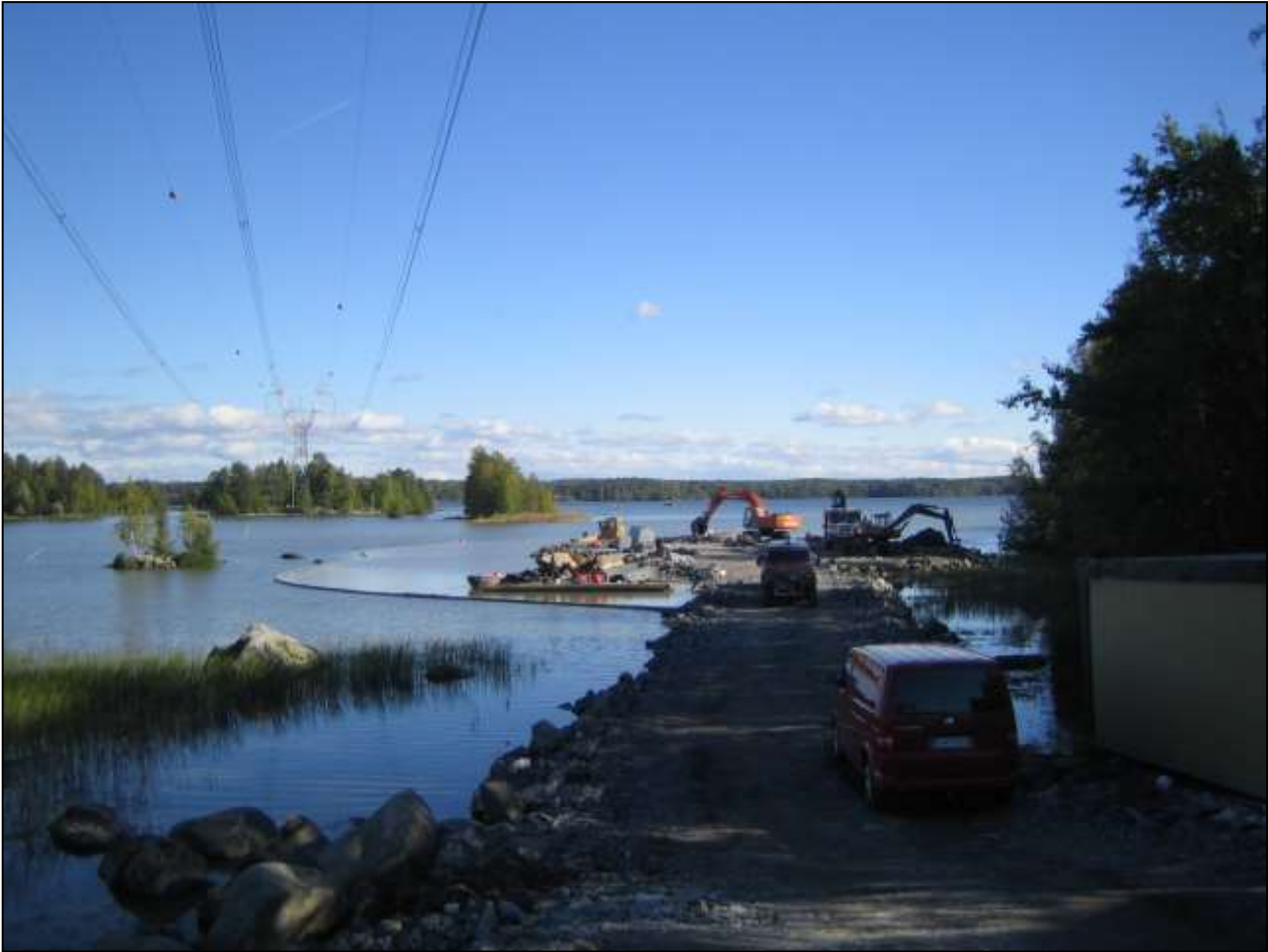
Kuva 14. Lähellä rantaa sijaitsevan vesistöpylvään rakentaminen vaatii yleensä väliaikaisen tieyhteyden.
