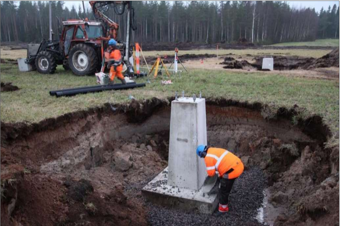
Kuva 10. Pylvään perustuselementin asentaminen.
