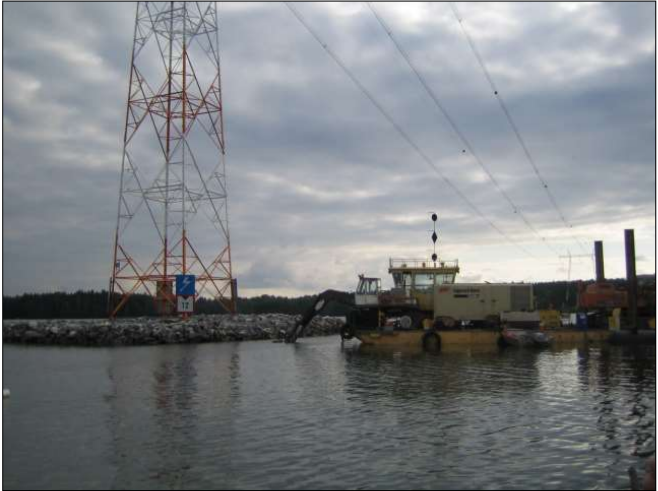
Kuva 15. Vapaasti seisovan pylvään tekoluodon reunaluiskojen viimeistelyä Pyhäjärvellä Pirkkalassa.
