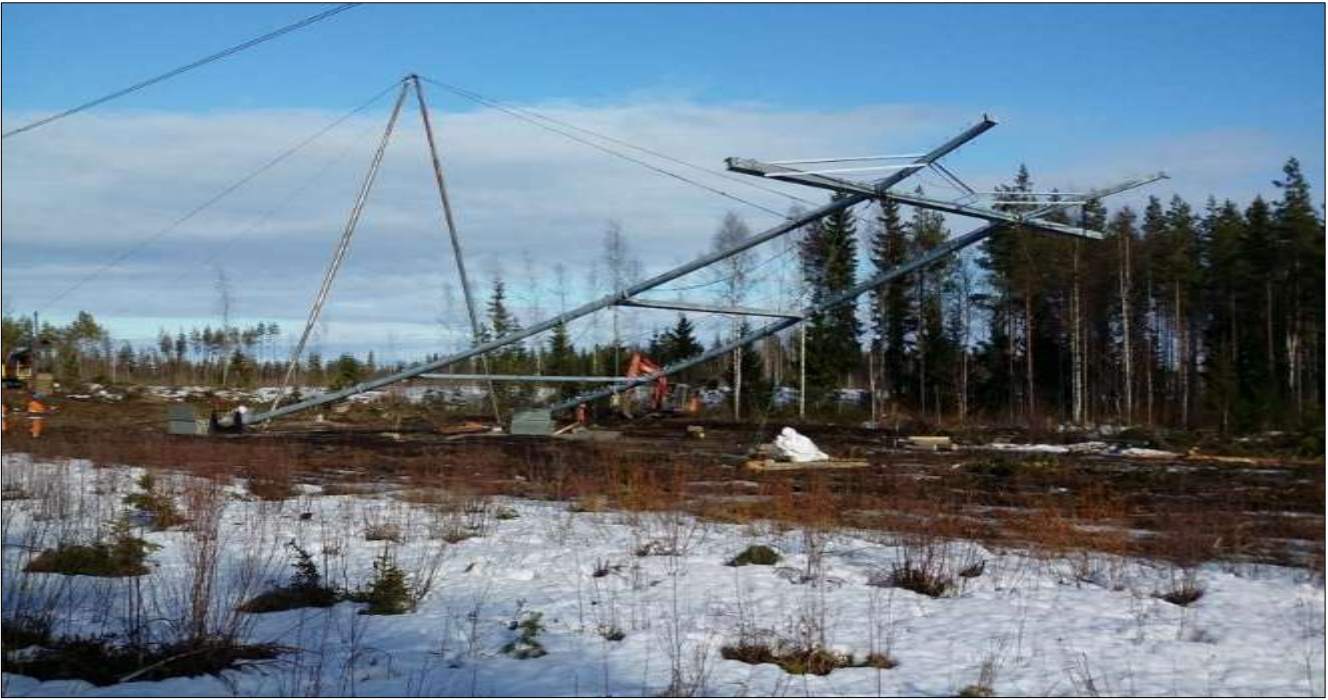
Kuva 12. Voimajohtopylvään pystytys.
