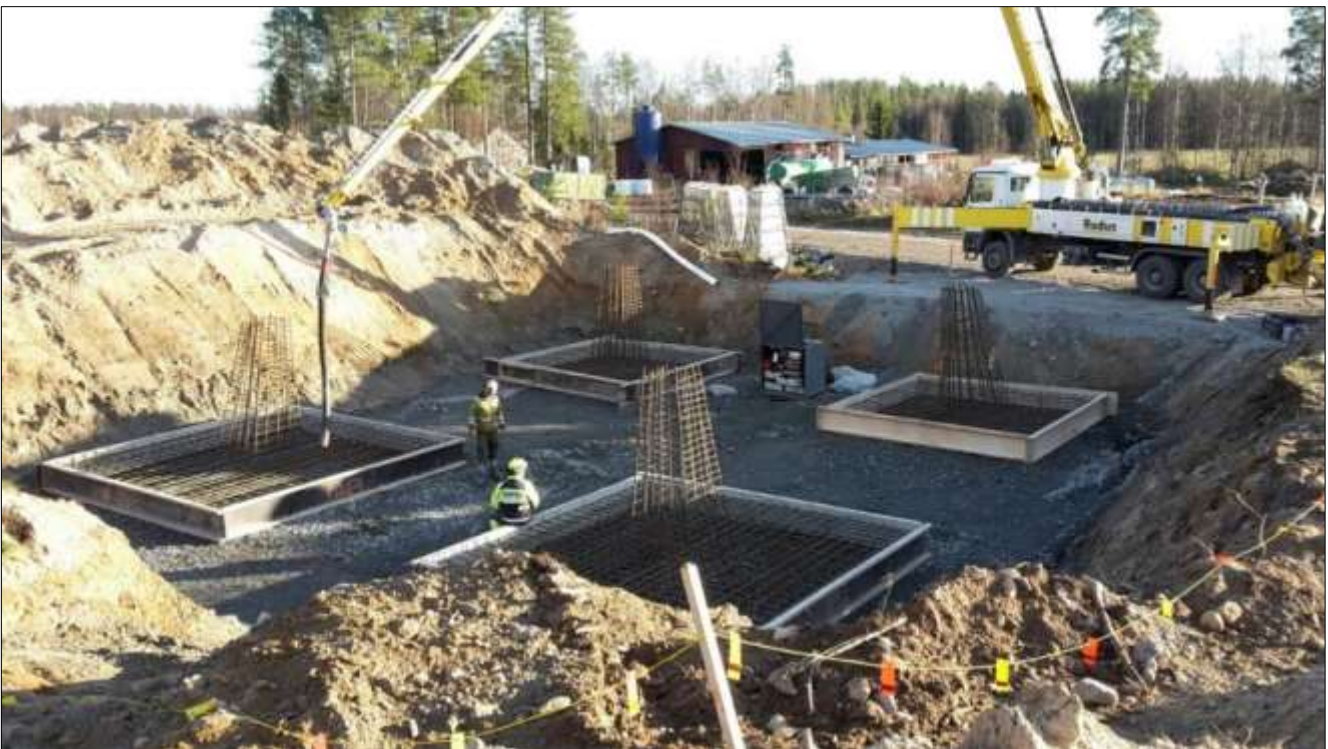
Kuva 11. Vapaasti seisovan pylvään perustuksen pohjatöitä.
