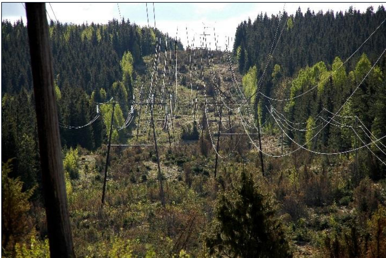
Kuva 13. Esimerkki valikoivasta raivauksesta.
