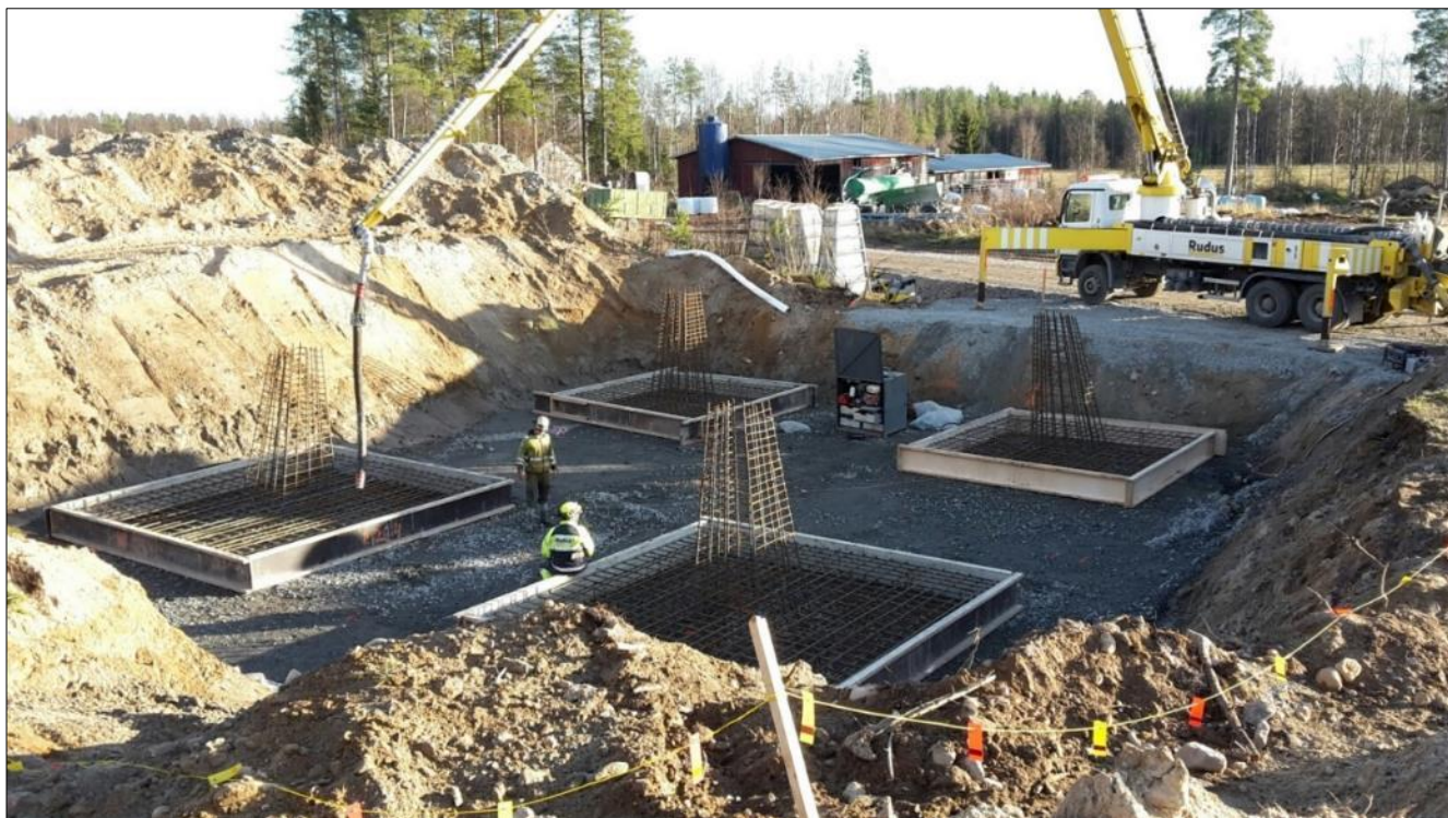
Kuva 10. Vapaasti seisovan pylvään perustuksen pohjatöitä.
