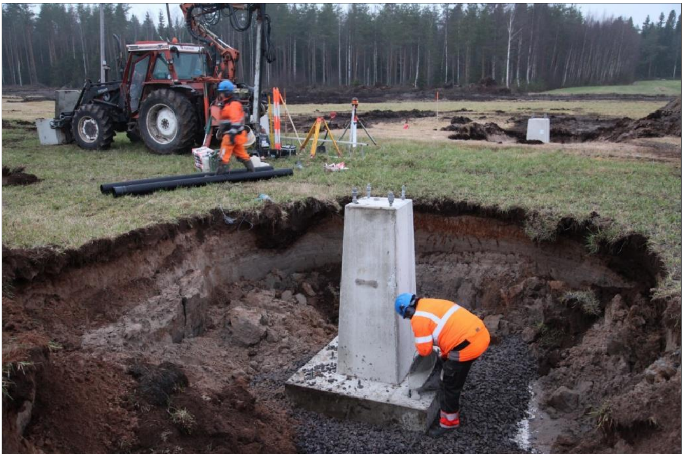
Kuva 9. Pylvään perustuselementin asentaminen.
