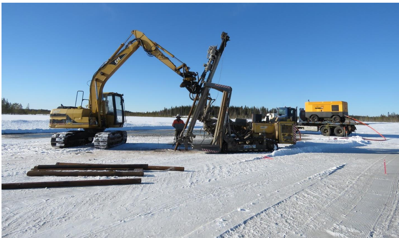
Kuva 11. Porapaaluperustuksen tekoa suoalueella, jossa työalue on jäädytetty.
