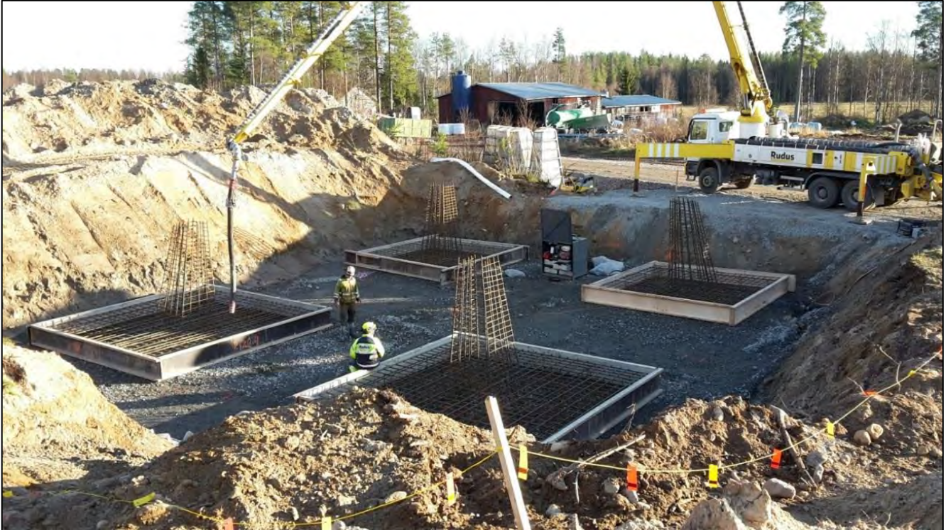
Kuva 8. Vapaasti seisovan pylvään perustuksen pohjatöitä.
