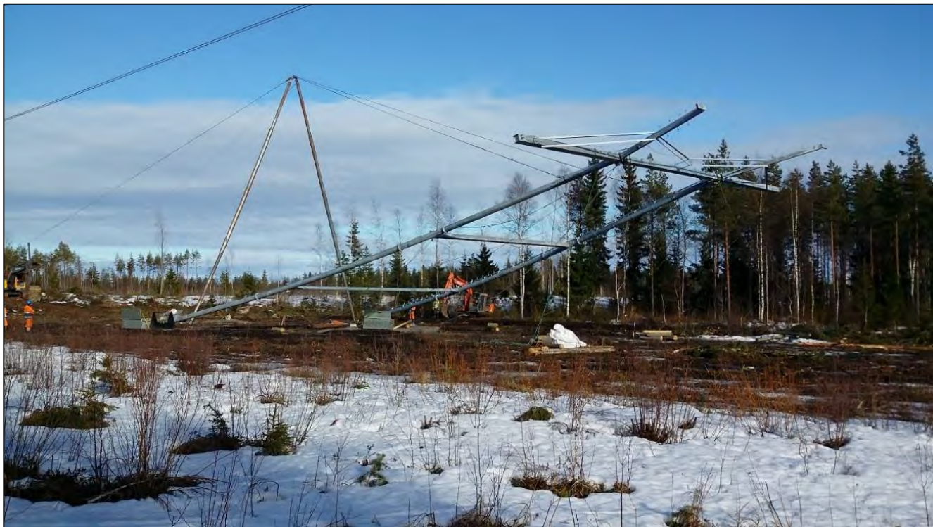
Kuva 9. Voimajohtopylvään pystytys.
