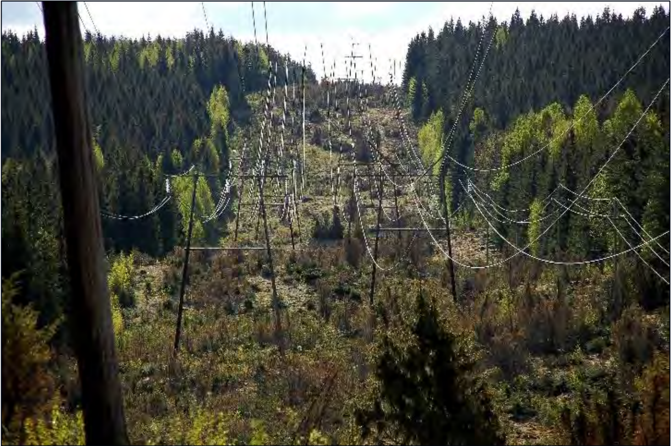
Kuva 10. Esimerkki valikoivasta raivauksesta.
