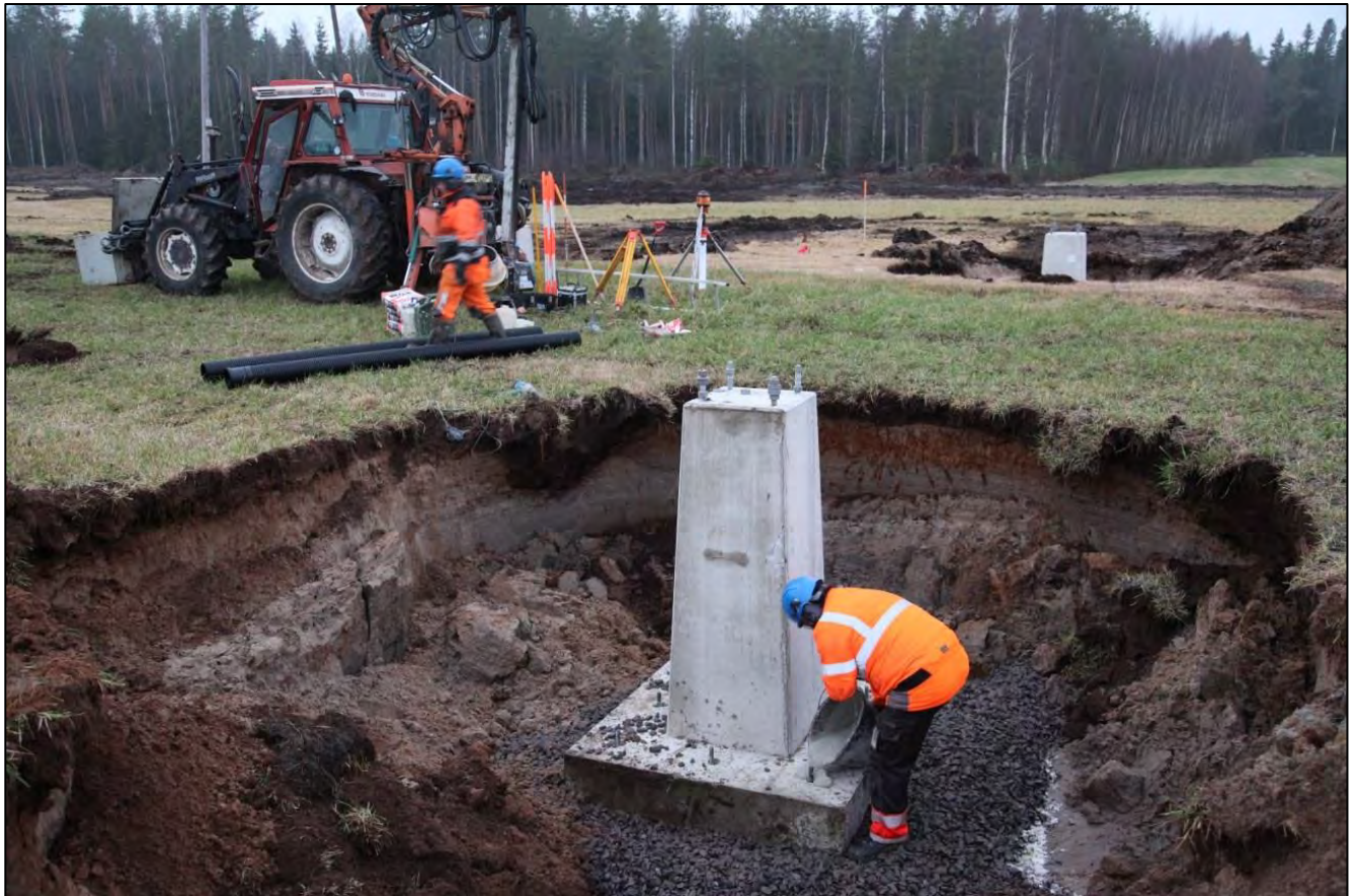
Kuva 7. Pylvään perustuselementin asentaminen.
