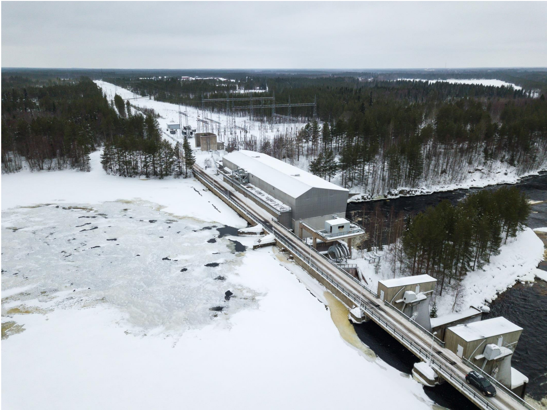
Kuvauspaikka 3. Utsen voimalaitos. Nykyinen voimajohto ja sähköasema.
