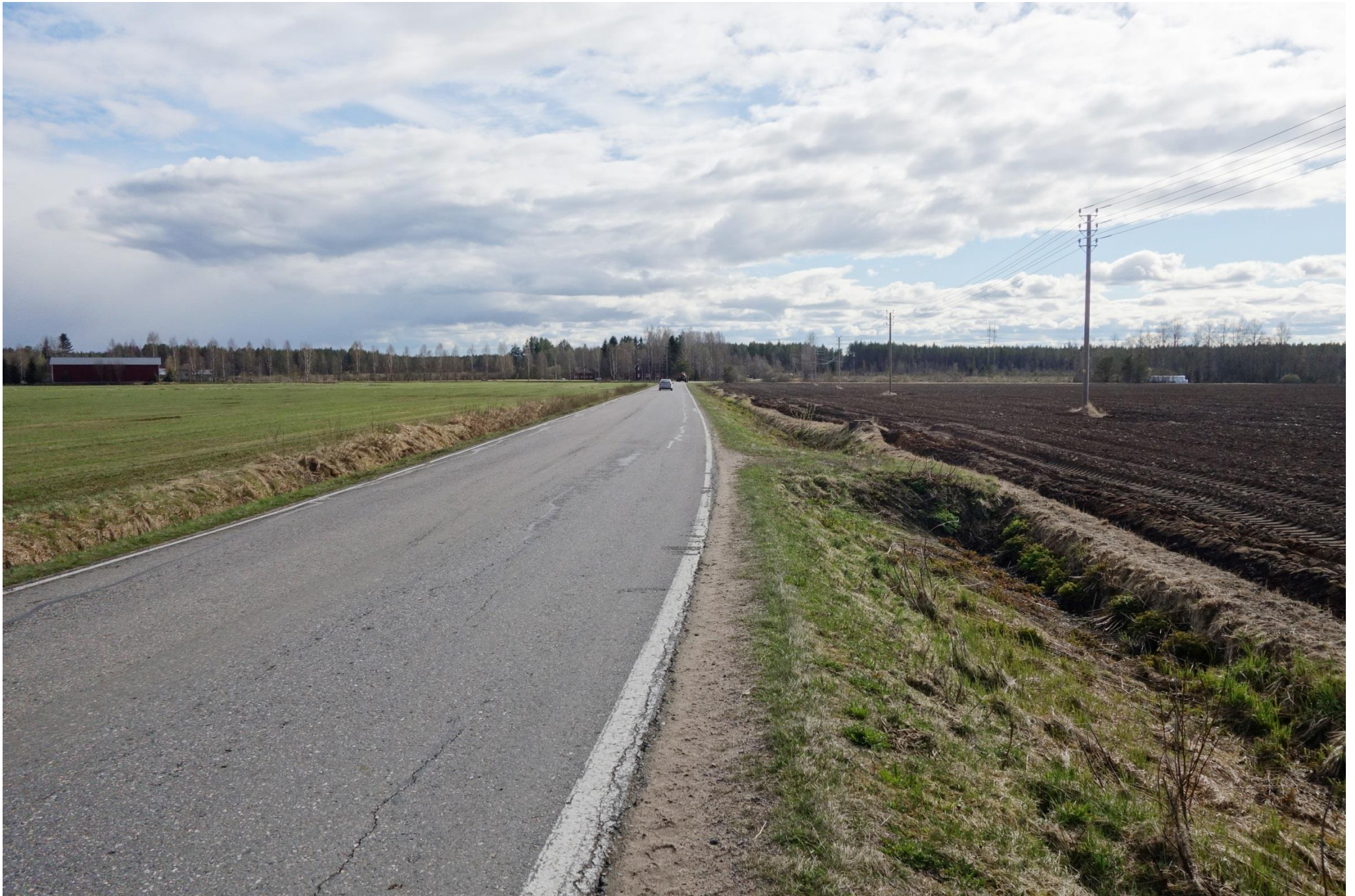
Kuvauspaikka 4. Ojakylä, johto-osuus B. Nykyinen voimajohto erottuu juuri ja juuri taustamaisemassa puiden latvusten yläpuolella.
