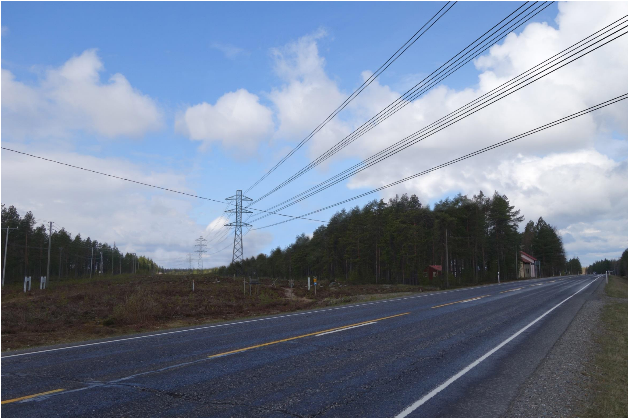
Kuvauspaikka 2. Utanen. Asuinrakennukset Kajaanintien varressa voimajohdon läheisyydessä tilanteessa kun johto-osuus C on toteutunut. Nykyinen voimajohto on purettu ja uusi voimajohto rakennettu lähemmäs asuinrakennuksia. Voimajohdon ja rakennusten väliin jää edelleen suojapuustoa.
