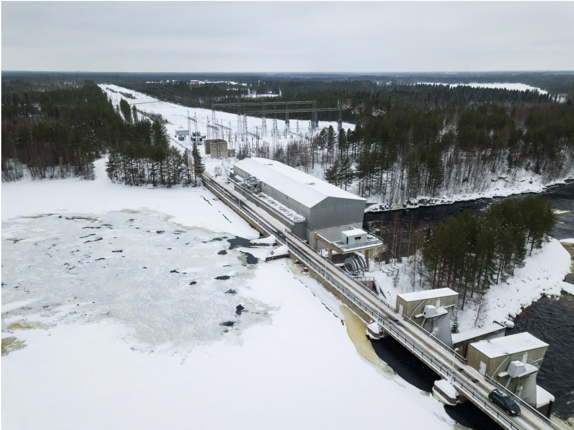
Kuvauspaikka 3. Utasen voimalaitos. Nykyinen voimajohto on purettu ja uusi voimajohto C on rakennettu johtoaukean oikeaan reunaan.
