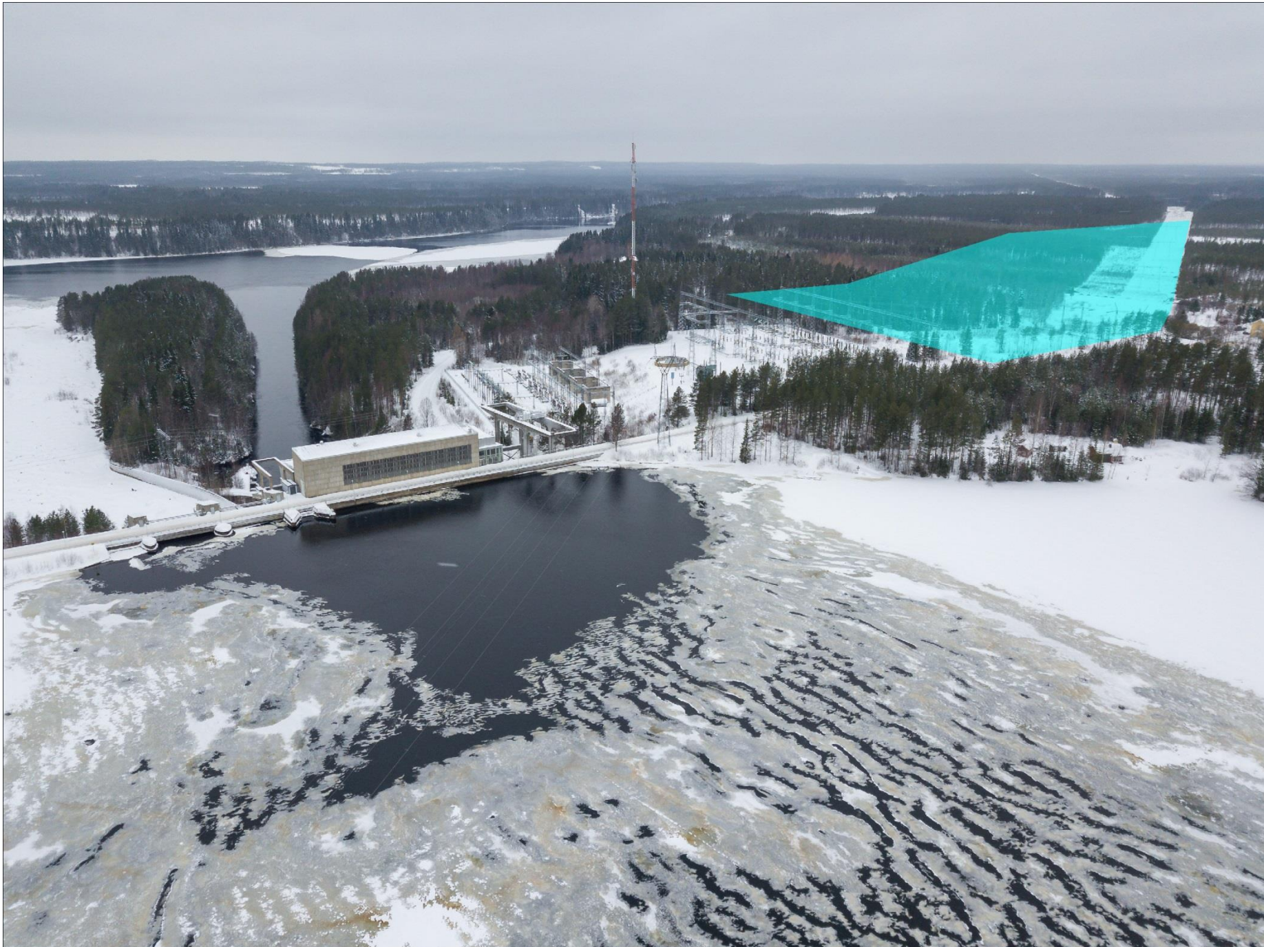
Kuvauspaikka 9. Nuojua. Kuvaan on havainnollistettu Nuojuan sähköaseman selvitysalue. Lähin asuinrakennus sijoittuu aivan kuvan oikeaan reunaan. Uusi voimajohto ei sijoitu nykyistä voimajohtoa lähemmäs asuinrakennusta.
