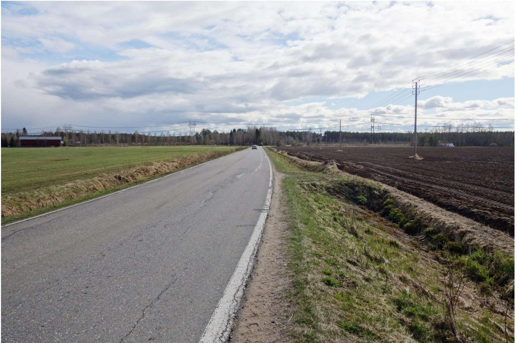
Kuvauspaikka 4. Ojakylä. Voimajohtoreittivaihtoehto B1 sijoituu nykyisen voimajohdon etupuolelle lähemmäs kyläasutusta.
