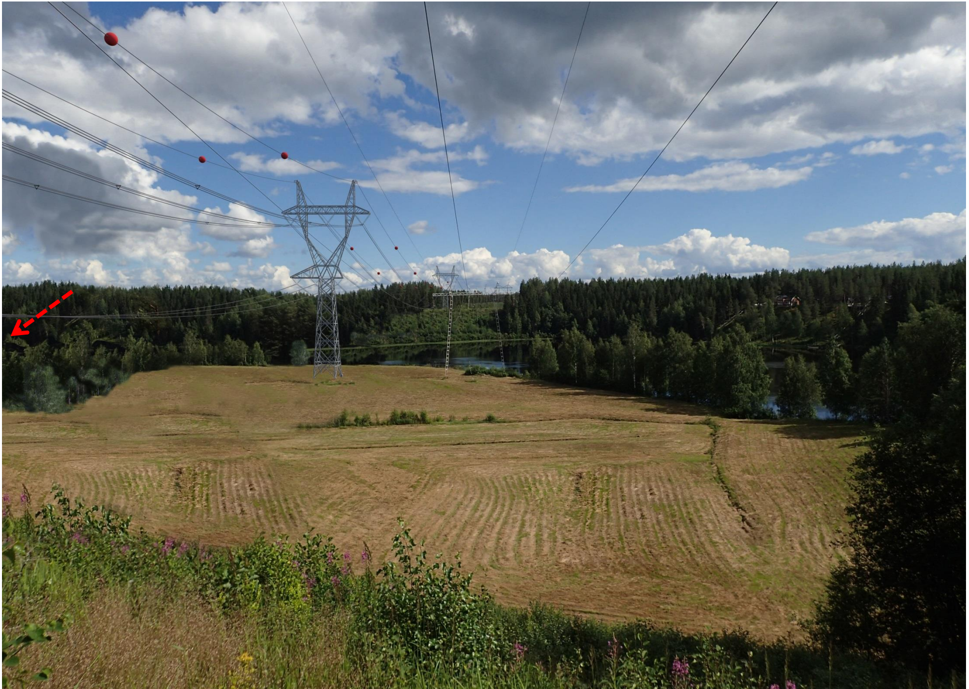
Kuvauspaikka 6. Talliniemi, johto-osuudella B. Voimajohtoreittivaihtoehto B1 sijoittuu kuvassa nykyisen voimajohdon vasemmalle puolelle eli itäpuolelle. Kuvaussuunta itään. Talliniemessä sijaitsevan asuinrakennuksen sijainti on osoitettu suuntaa-antavasti punaisella nuolella.
